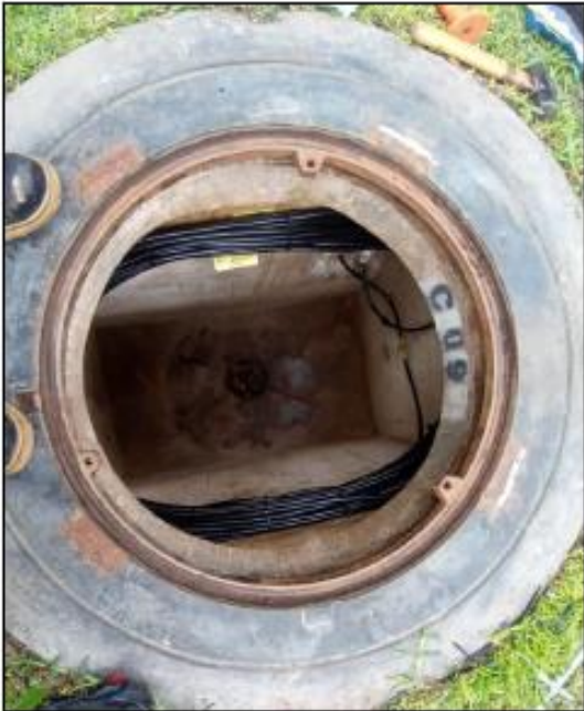
Tipo de identificación de cámara de comunicaciones
