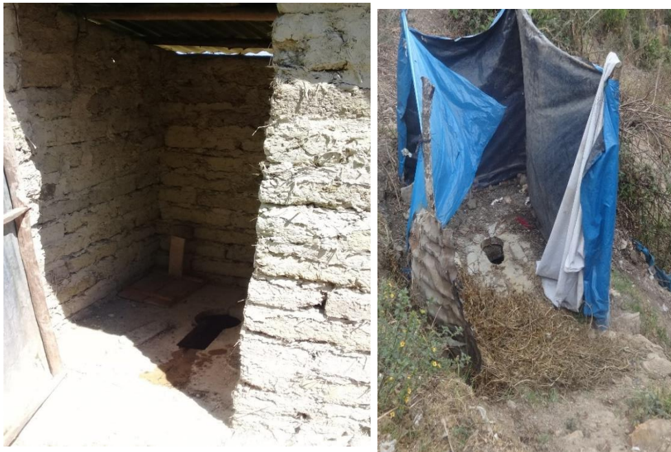
Imagen Nº 9: Pozos de Hoyo seco en pésimas condiciones.
