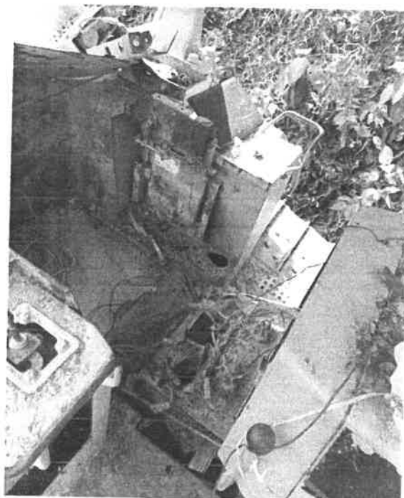
2. CABINA DE UNIDAD CON RASTROS DE QUEMADURAS
