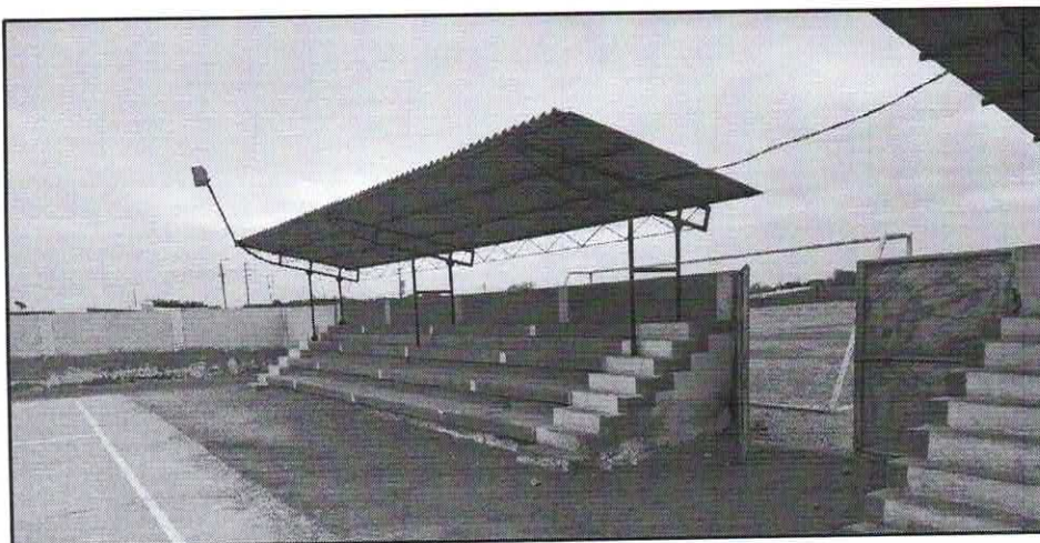
Imagen N° 02: Graderia en mal estado de conservación
