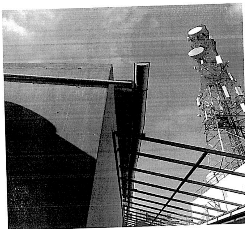
Canaletas de aguas pluviales deterioradas y oxidadas
