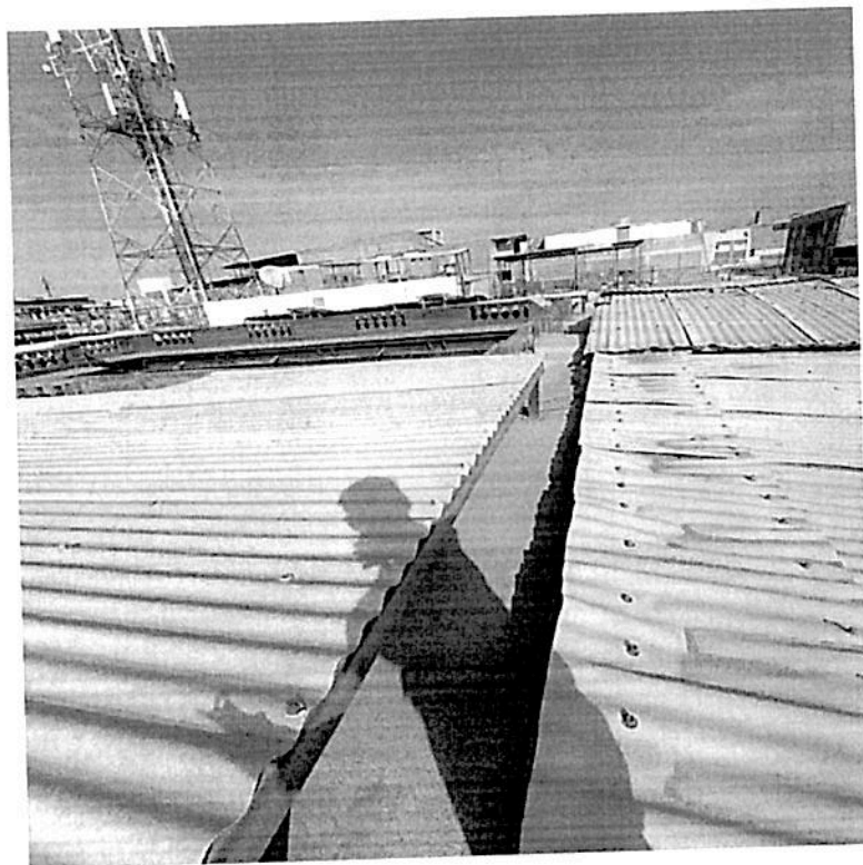
Techos inclinados en mal estado, presenta problemas de evacuación pluvial
