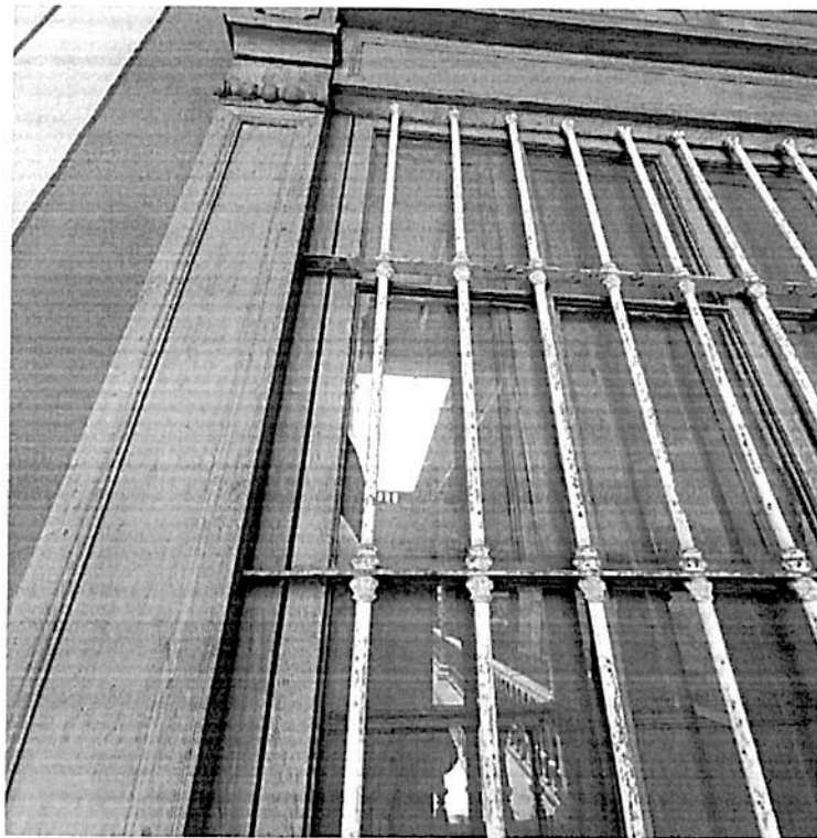
Protectores de hierro deteriorados, vidrios rotos
