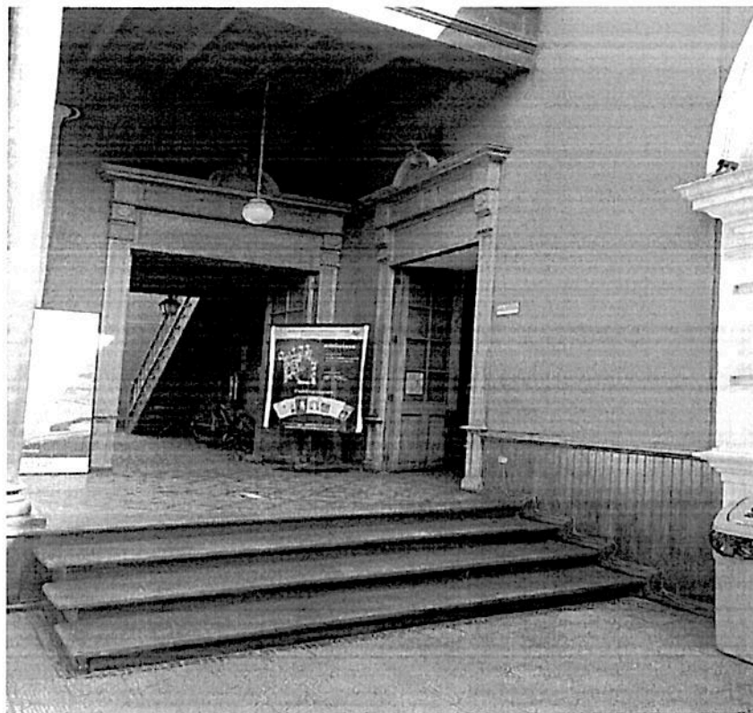
Escaleras de madera y revestimientos deteriorados por el tiempo
