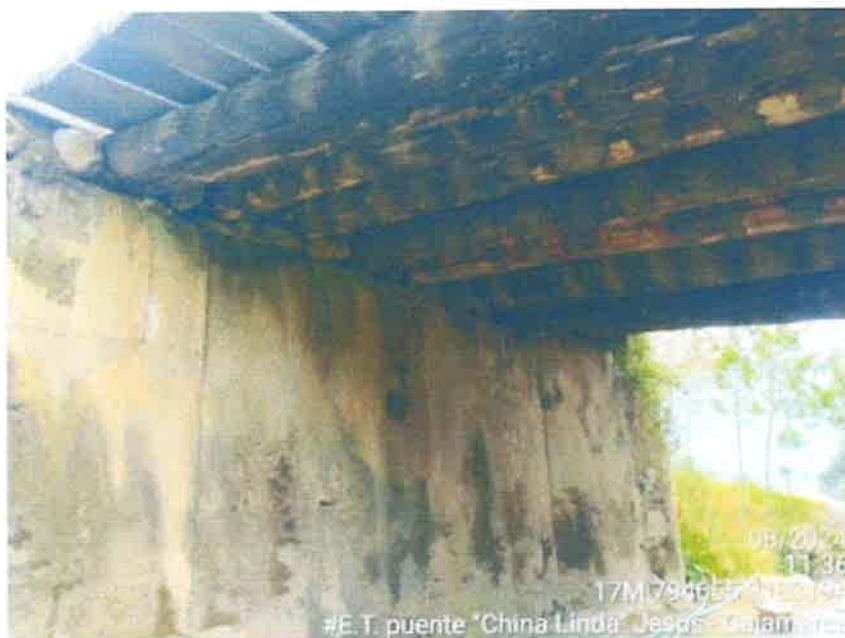
Fotografía N°4: Vista de la parte inferior del puente, donde se muestra vigas de madera y apoyos deteriorados.
