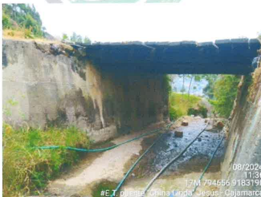
Fotografía N° 3: Vista de la parte inferior del puente, donde se muestra existencia de concreto en el lecho del cauce.
