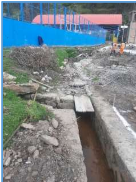
Foto 02: Se ve la unión del Canal Principal y Canal Secundario en mal estado.
