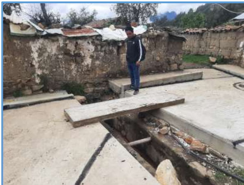
Foto 04: Se ve en mal estado el canal principal, además de que no hay vereda en el tramo del canal.
