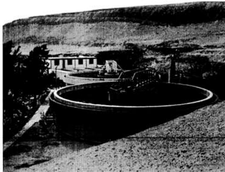
Planta de tratamiento de agua potable Cata Cata, capacidad instalada de 500 l/s, tecnología patentada Degremont.
