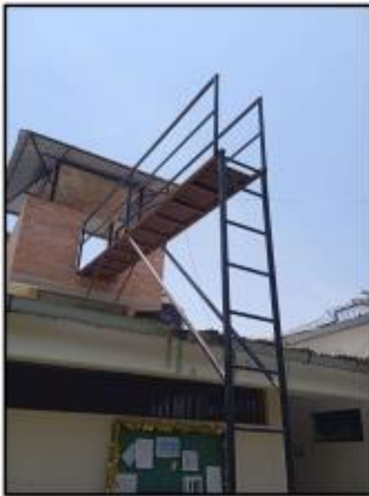
Imagen N° 6: Escalera de gato donde se colocará guarda hombres para proteger al personal de seguridad.
