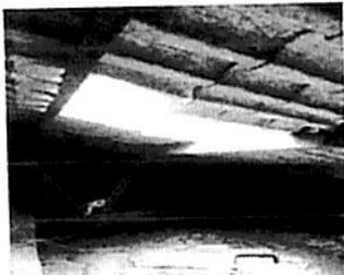
FOTO N°01 se observa el mal estado de la cobertura de UPSS Hospitalización.
