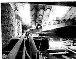
FOTO N°02: Vista interior del área a intervenir en el cual encontramos filtraciones, cieloraso en mal estado
