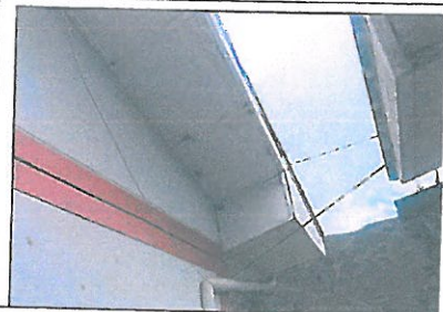
FOTO N.º 05: existe filtración en los cielorrasos, lo que ocasiona el desprendimiento del triplex y goteo.
