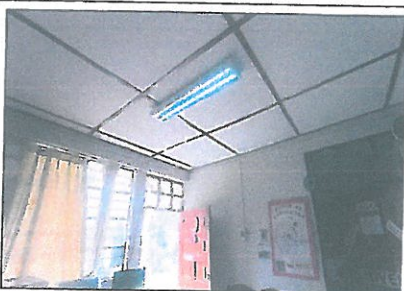
FOTO N.º 11: Se puede apreciar la instalación de luminaria, no se encuentra funcionando la luminaria completa.
