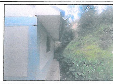
FOTO N.º 14: Las canaletas exteriores se encuentran el mal estado, lo que ocasiona que ocurra filtraciones y deterioro de la pintura ante presencia de lluvias.
