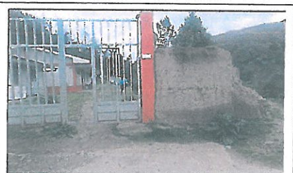
FOTO N.º 23: Cerco perimétrico se está desmoronando, propio del material y saturación de las mismas, se encuentra en mal estado.
