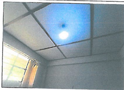
FOTO N.º 06: Se puede apreciar la instalación de luminaria, se encuentra funcionando sin las instalaciones eléctricas correctas (cableado y caja octogonal).
