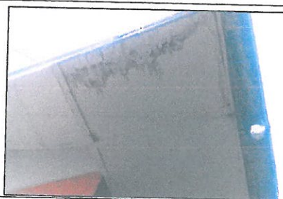
FOTO N.º 04: existe filtración en los cielorrasos, lo que ocasiona el desprendimiento del triplex y goteo.
