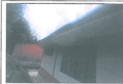
FOTO N.º 15: Las canaletas exteriores se encuentran el mal estado, lo que ocasiona que ocurra filtraciones y deterioro de la pintura ante presencia de lluvias.
