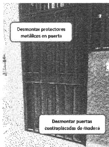
Figura 4. Desmontar puertas contraplacadas de madera de 01 hoja y protector metálico en primer nivel del bloque 41 – FIME.
