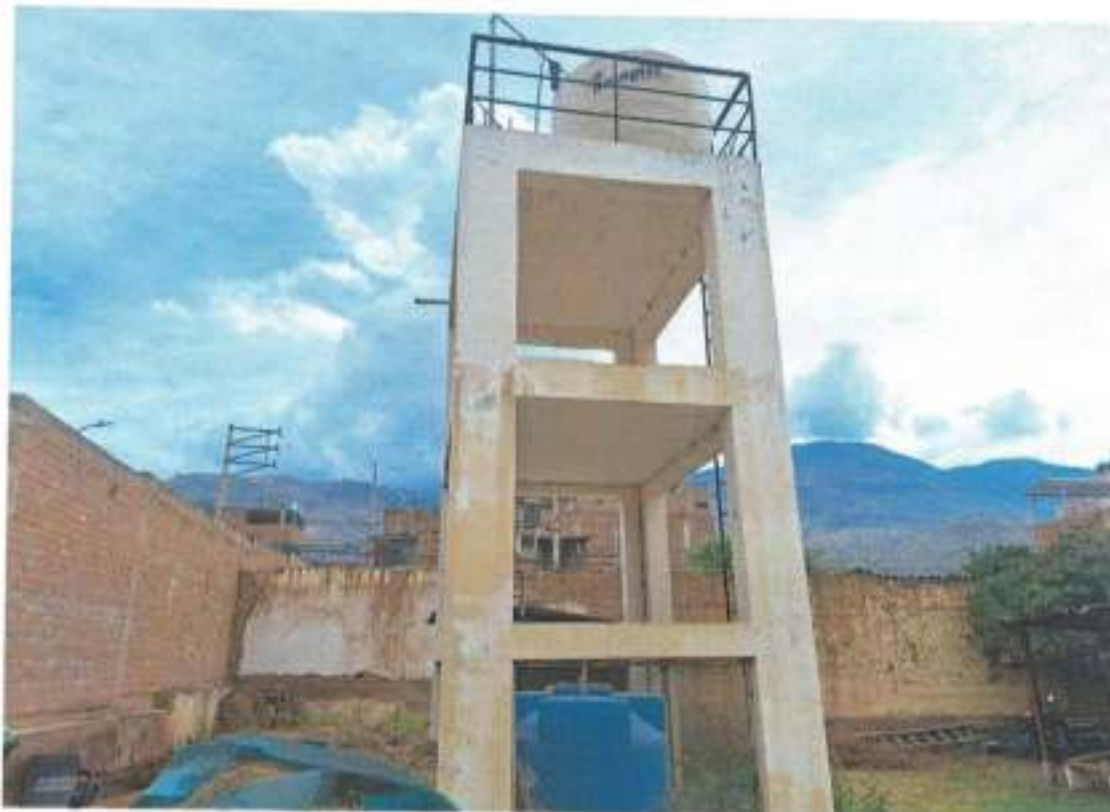
Foto 31: torre de cistema y tanque elevado
