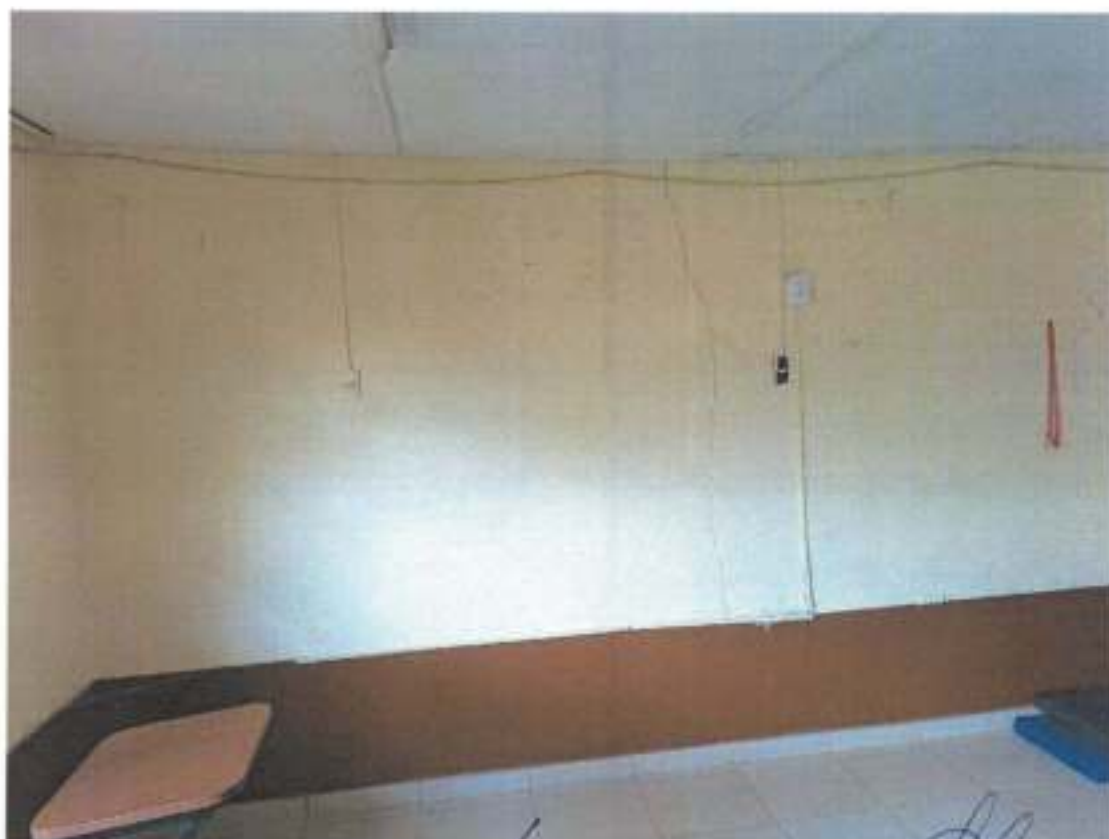
Foto 29: muros fisurados producto de los desplazamientos y asentamientos
