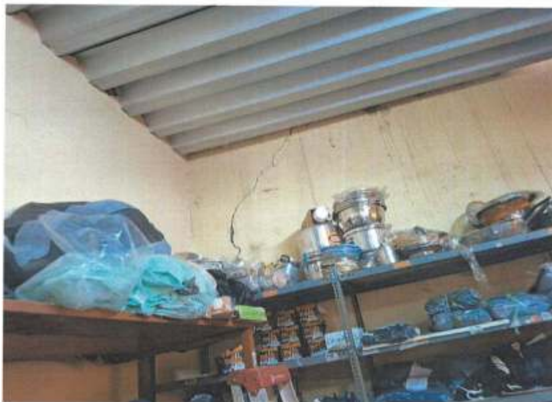
Foto 29: muros fisurados producto de los desplazamientos y asentamientos
