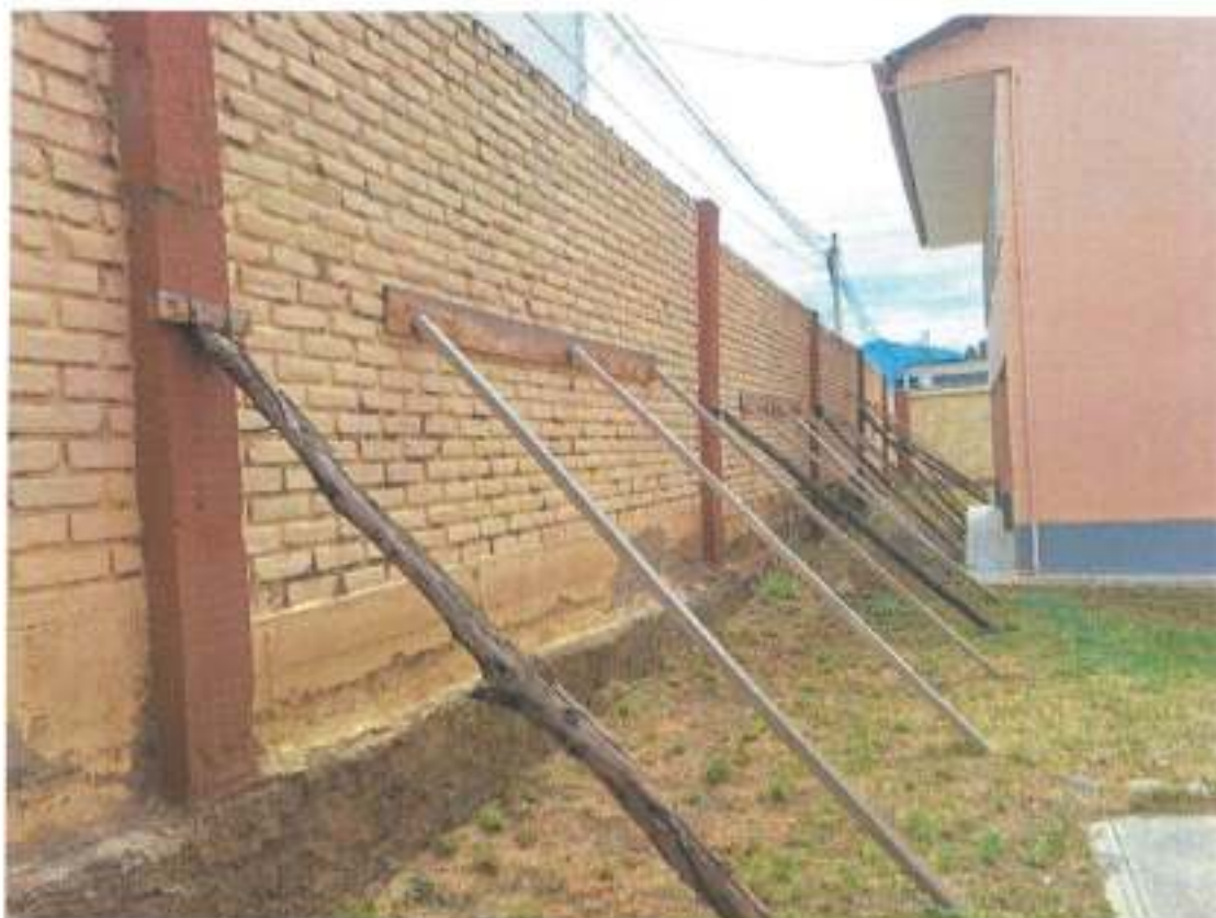
Foto 17: interior del cerco en el jirón 2 de mayo, vemos entibado con palos y tablas.
