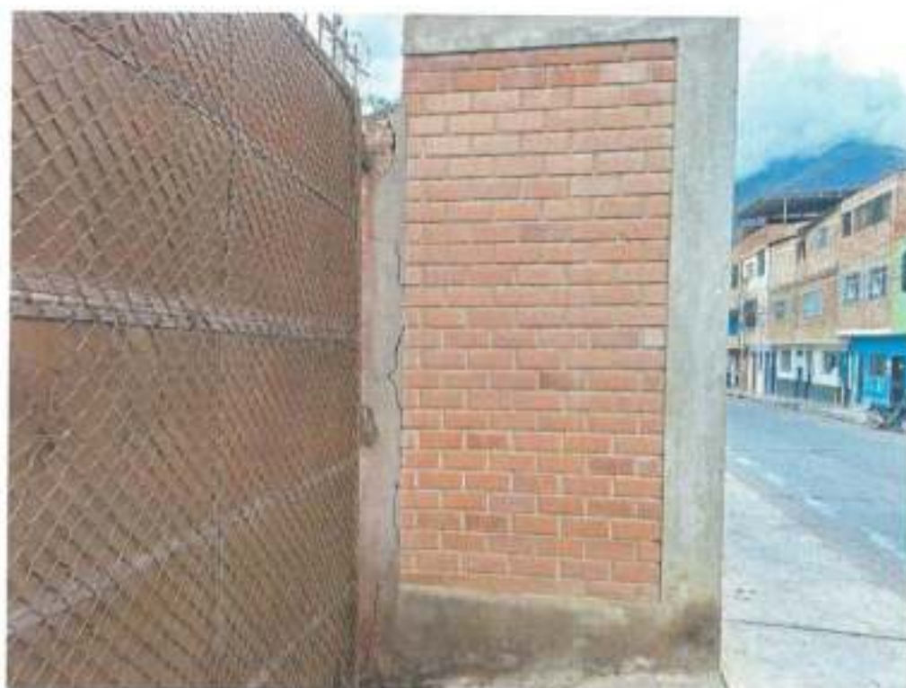
Foto 07: columnas deterioradas por el mal proceso constructivo
