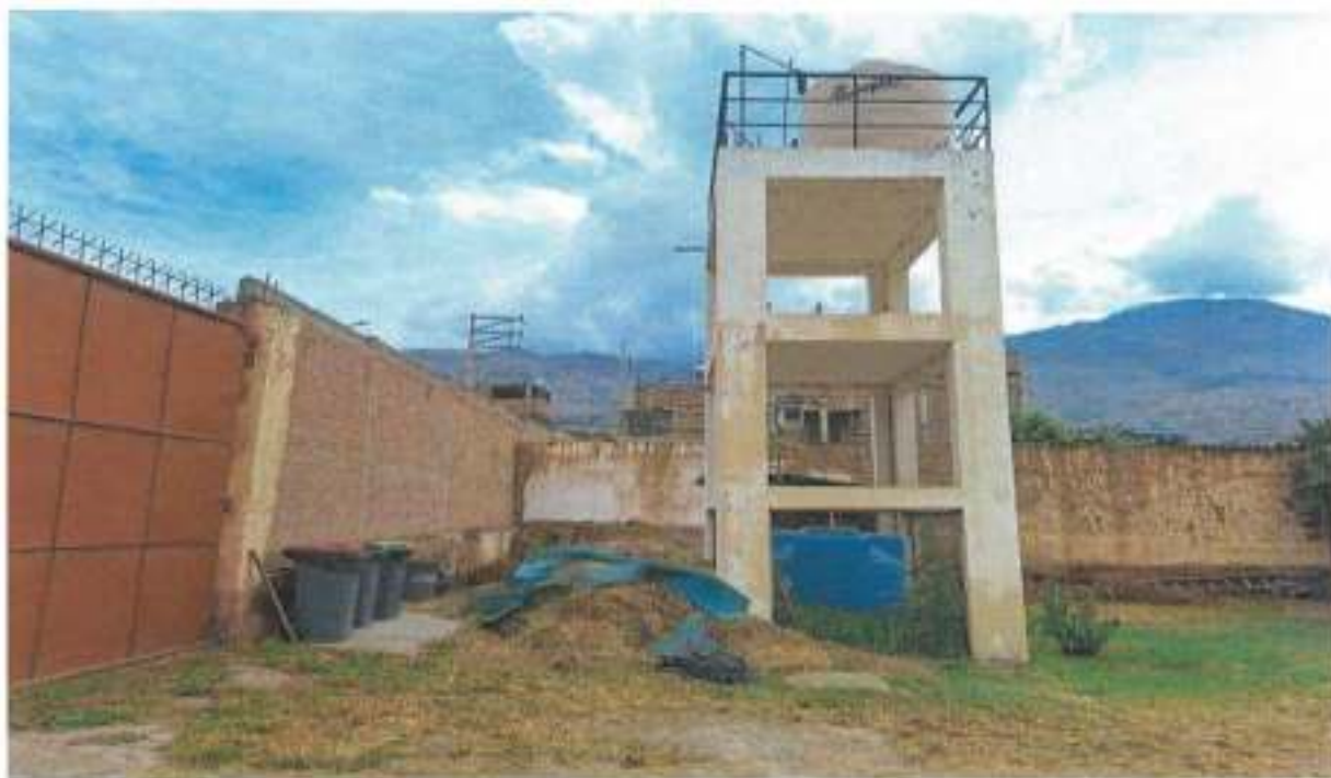
Torre de cisterna y tanque elevado, la cual satisface la demanda en el CAR
