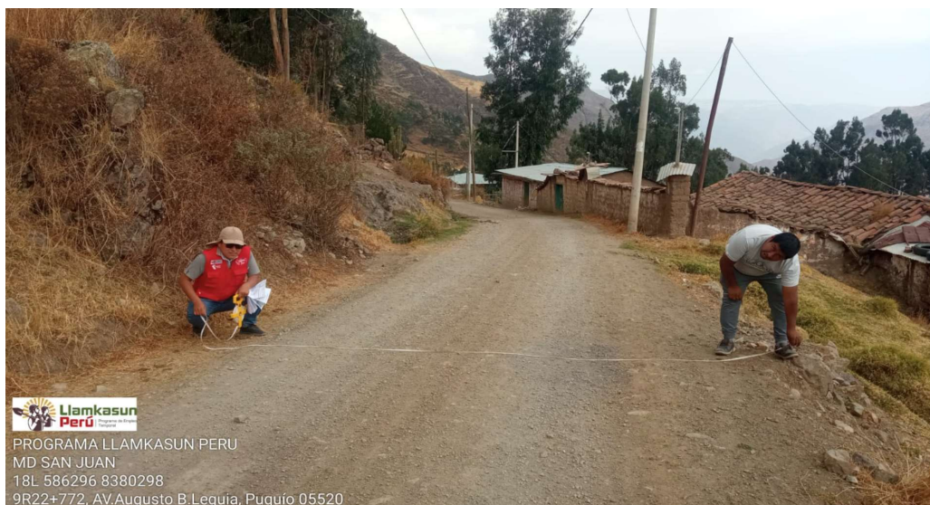
Fotografía 05: Se observa al ing. Evaluador en representacion del programa de Llamasun Peru, realizando la verificación de las medidas se la seccion de la pavimentacion que se plasmo en los planos. En mano del consultor en representacion de la entidad proponente.
