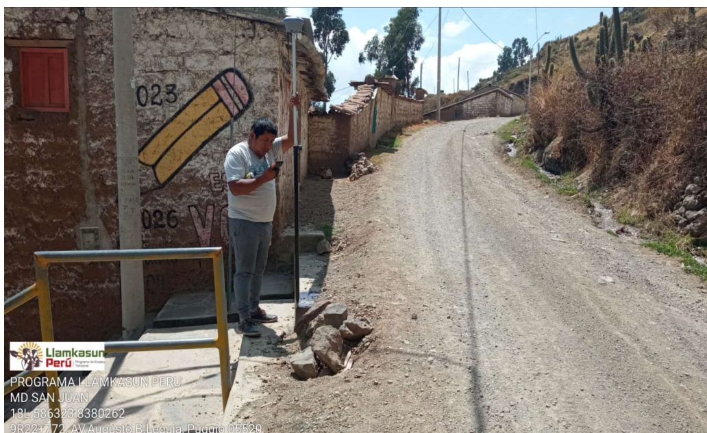
Fotografía 02, se visualiza la toma de un punto estrategico como punto axiliar para controlar el empalme de la pavimentacion con las gradas existentes (lado derecho de la via)
