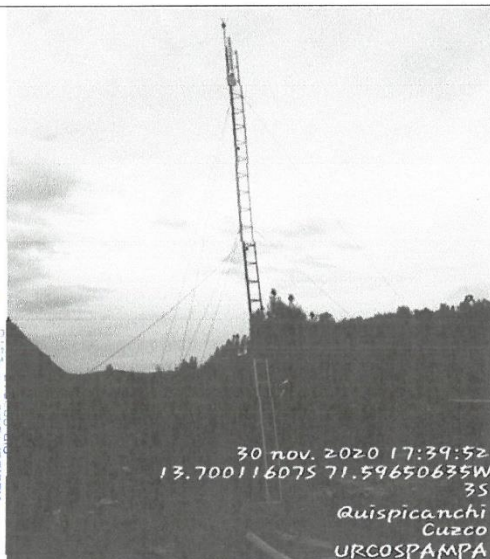
Fotografía N° 09: torre arriostrada en Cjunucunca
