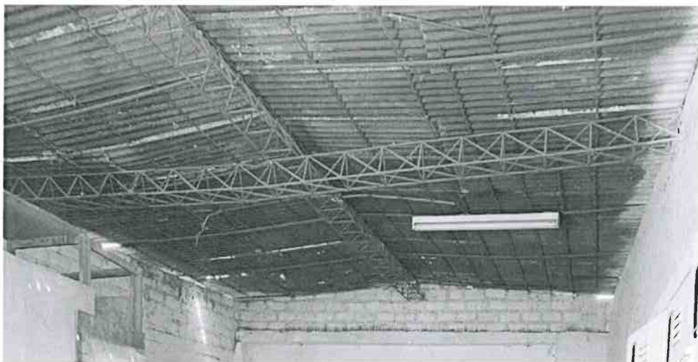
Foto N° 02 - Vista de las coberturas existentes. Se aprecia su mal estado
