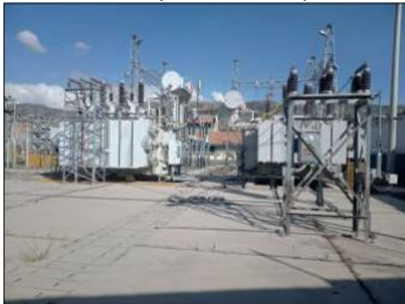
Fig. 21. Salidas en 10kV de los transformadores de la SET Ayacucho hacia la barra B4217.
