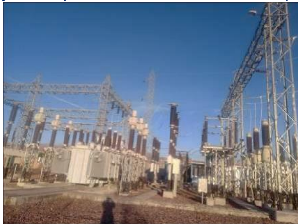
Fig. 23. Transformador de 50 MVA, 220/66/10kV de la SET Mollepata.
