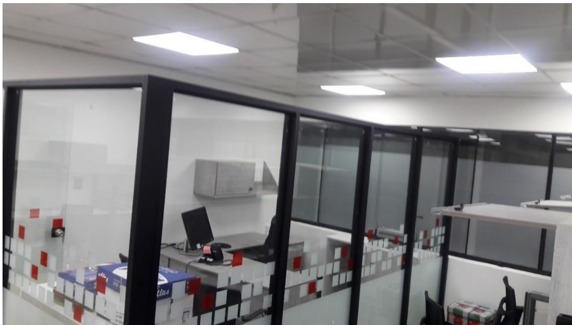
Imagen Referencial: Mampara instalada en otra oficina del MINCETUR, formato a replicar. Acabado en lámina Frost, diseño a coordinar con la supervisión de la SDSS.
