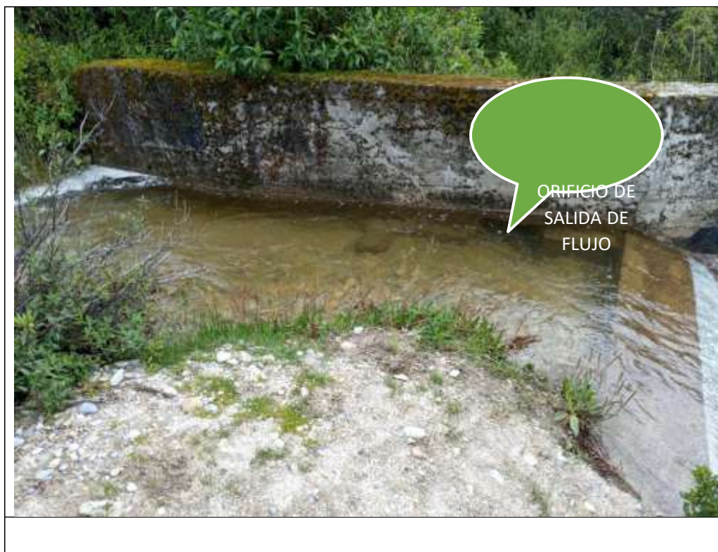
Fotografía N° 02: Vista panorámica de bocatoma en estado deterioro, no presenta compuerta solo un orificio para la salida de flujo
