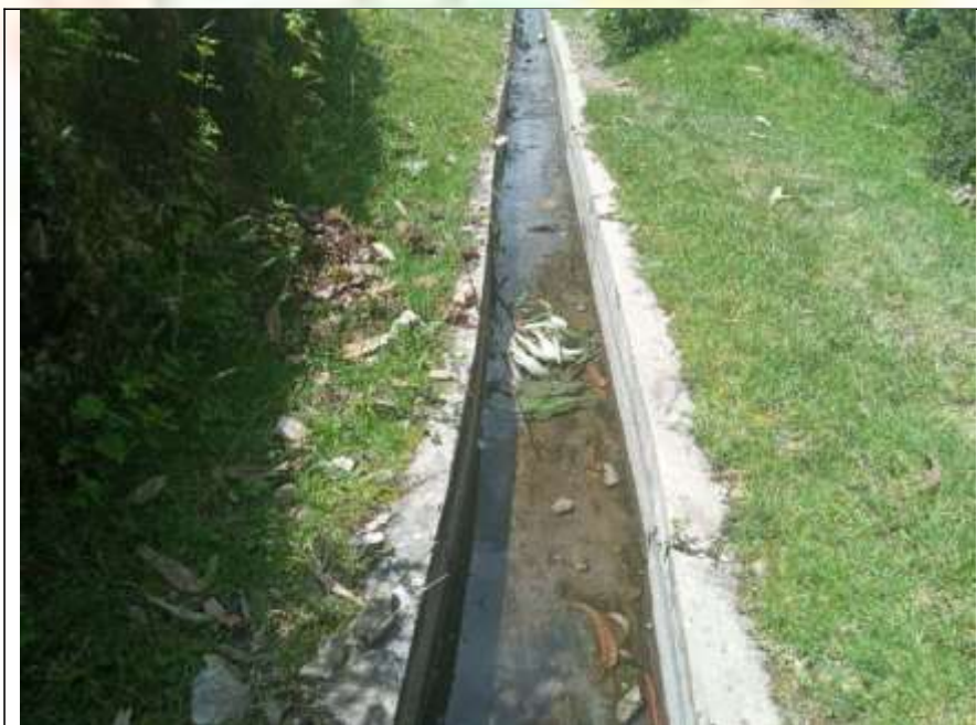
Fotografía N° 23: canal de forma rectangular 0.40*0.30m
