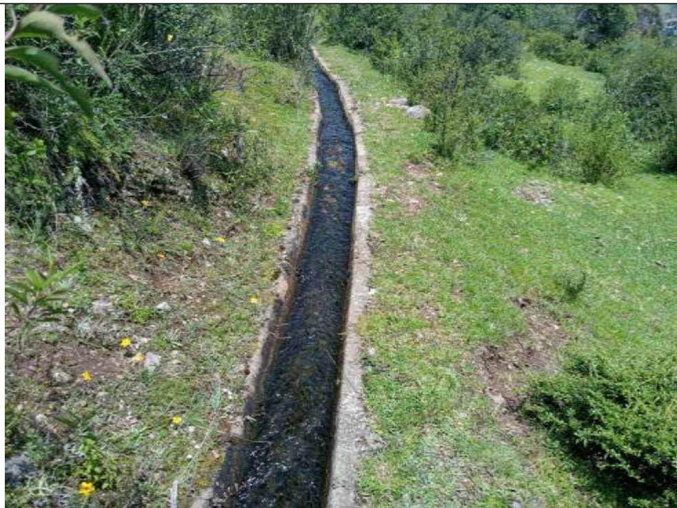
Fotografía N° 14: canal de concreto de forma trapezoidal 0.20x0.20x0.30m.
