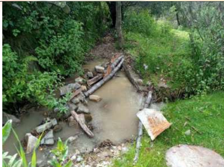
Fotografía N° 28: Desarenador artesanal de tierra en pésimas condiciones
