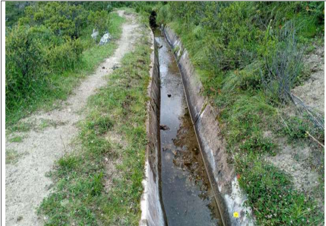
Fotografía N° 03: Vista panorámica de canal existente forma trapezoidal con medidas 0.45*0.60*0.40m
