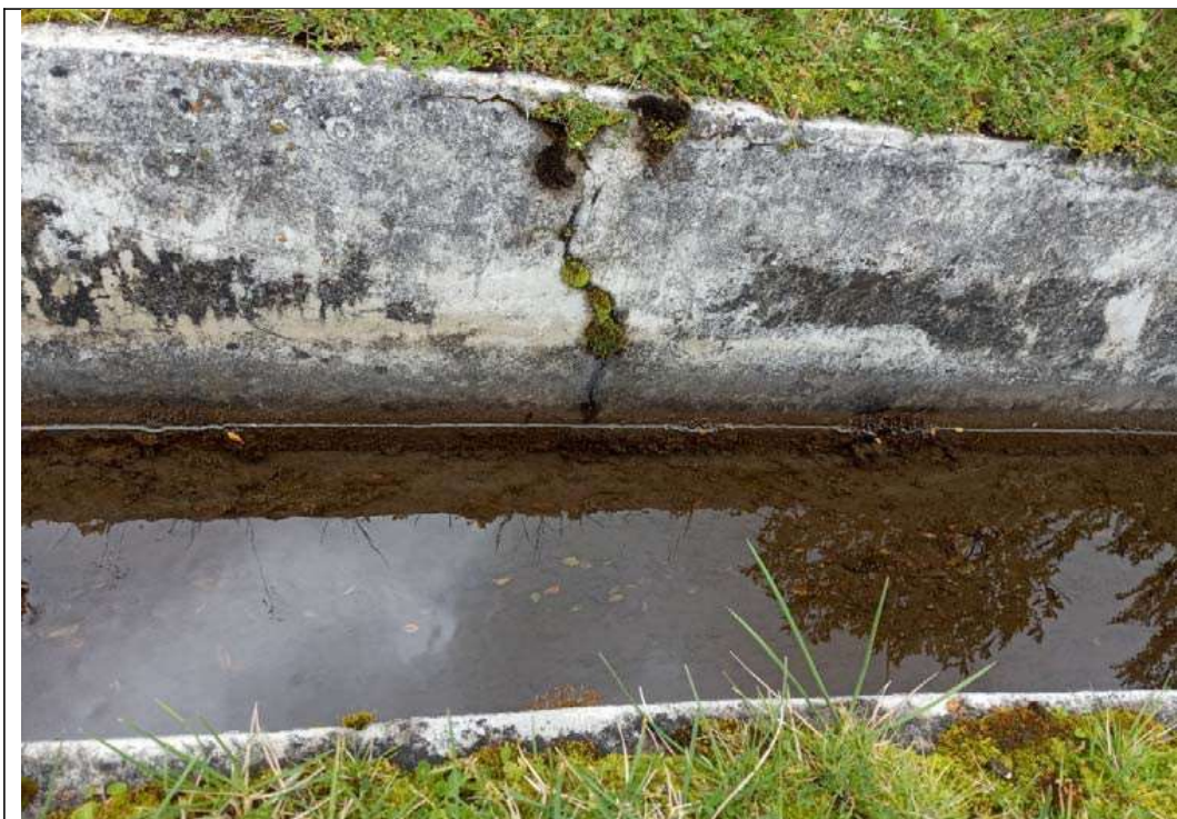
Fotografía N° 04: Se muestra base y lateral de canal concreto con fisuras
