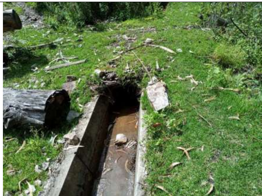
Fotografía N° 24: Registra artesanal de pase aéreo utilizando material de la zona
