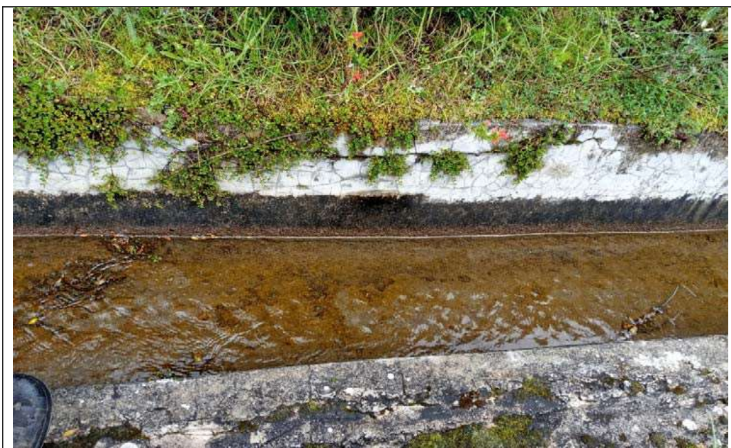
Fotografía N° 05: Canal de concreto en estado deterioro generalizado y invadidas con hierbas
