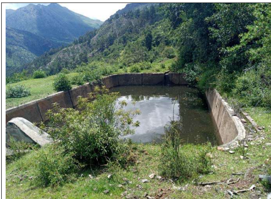
Fotografía N° 15: Reservorio existente cap: 317 m3, su estado operativo
