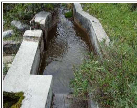
Fotografía N°08: Desarenador existente
