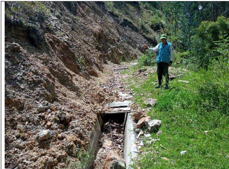
Fotografía N° 22: Material de la zona utilizado para proteger la colmatación de material hacia canal, producto de caída del talud de canal
