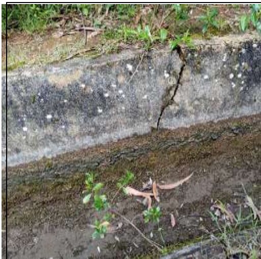
Fotografía N° 19: Fisura en lateral de canal
