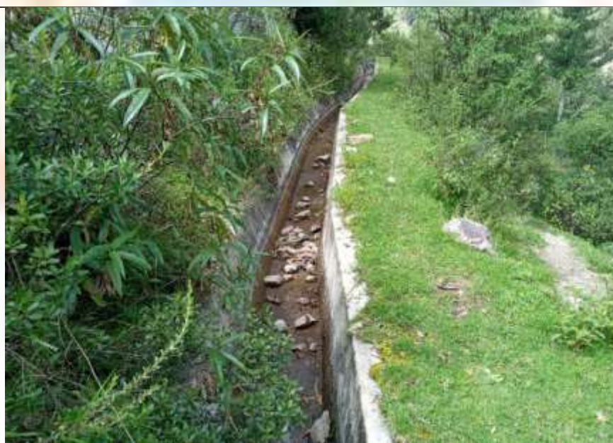
Fotografía N° 21: Vista panorámica de canal de forma trapezoidal con medidas 0.50*0.60*0.70m
