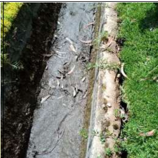
Fotografía N° 20: Colapso de base de canal
