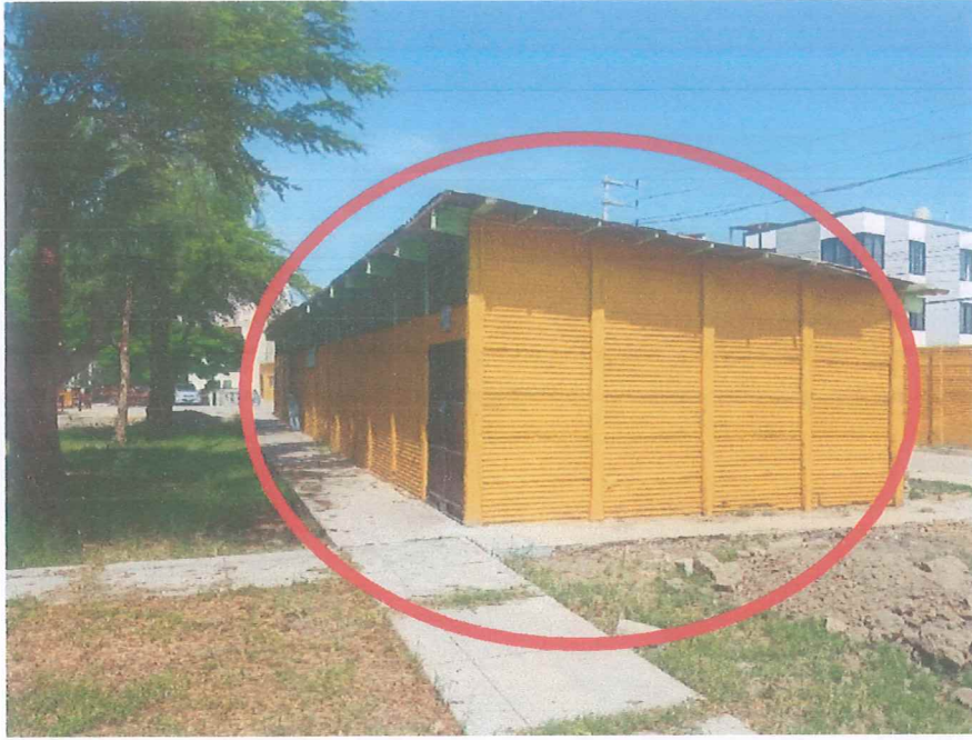
Figura 63. Pintura de muros, columnas, vigas, derrames en puertas y ventanas de exteriores del T-1.
