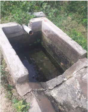
Poza de Descarga en mal Estado
