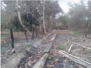
Canal en mal estado (asentamiento entre juntas)
