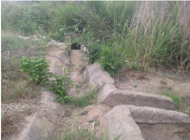
Canal en mal estado (toma parcelera deteriorada)
