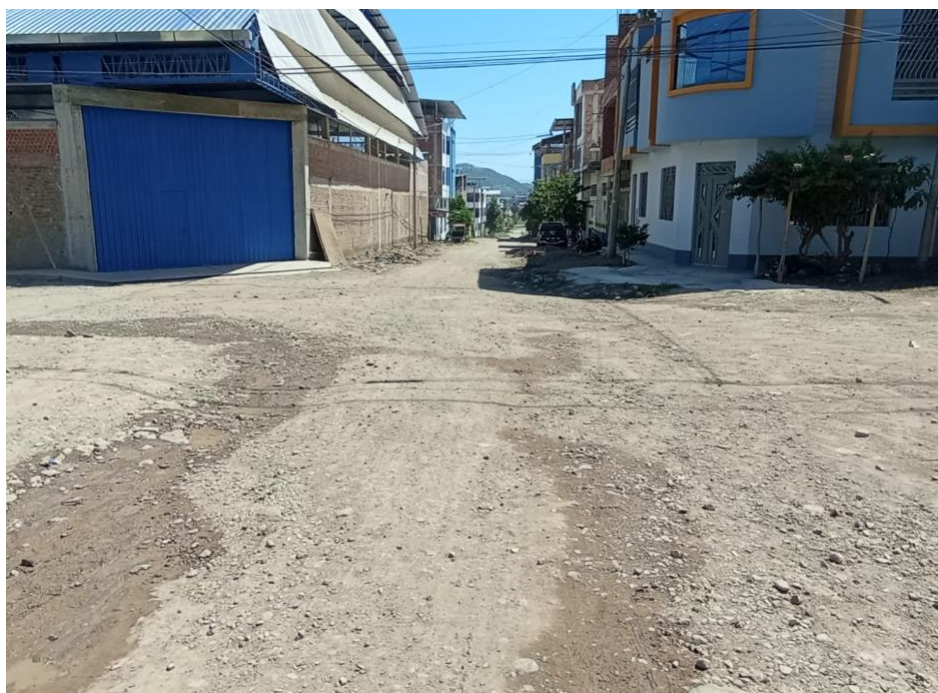
IMAGEN 02: CUADRA 02 CALLE SIN PAVIMENTAR Y ESTRUCTURAS PARA UN DRENAJE, LAS AGUAS EROSIONAN AL AFIRMADO
