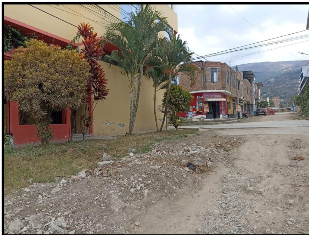
IMAGEN 07: CUADRA 04 CALLE SIN PAVIMENTAR AFIRMADO DETERIORADO DEBIDO QUE LA CALLE NO TIENE UN BUEN DRENAJE.
