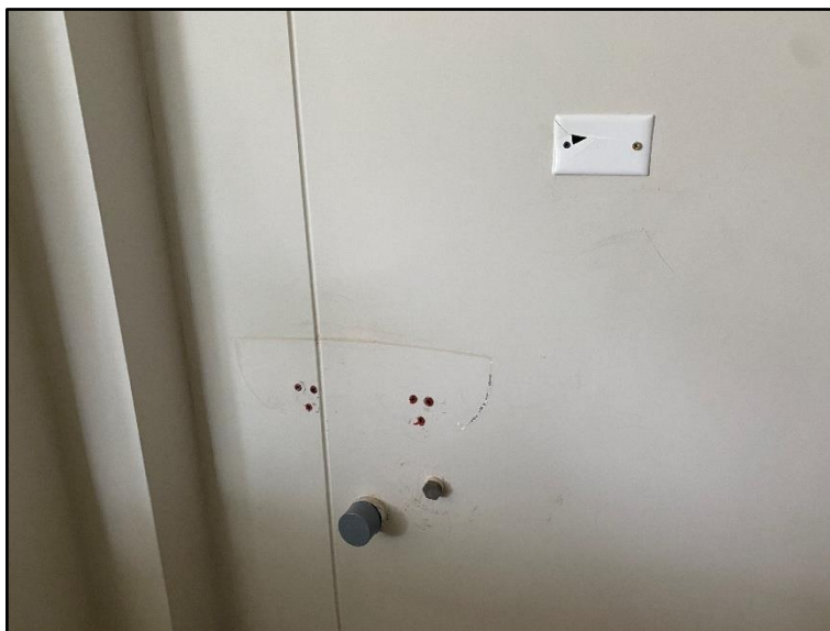
Ilustración 2: Se evidencia el punto de agua y desagüe muy expuesto.
