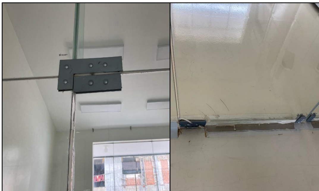
Ilustración 6: Se evidencia las bisagras de la mampara en mal estado de conservación.
