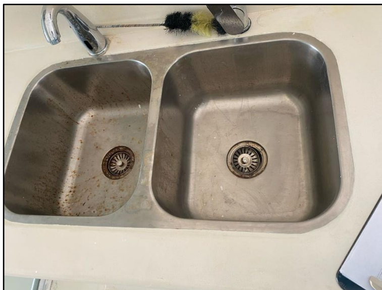
Ilustración 9: Se evidencia el óxido en lavaderos en mal estado de conservación.
