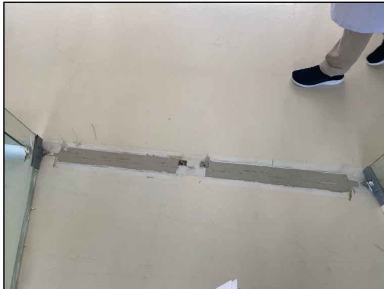
Ilustración 7: Se evidencia el manchado y desprendimiento de porcelanato liquido en piso y zócalo.
