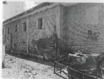
Muros deteriorados con presencia de fallas como humedad, desprendimiento de material, grietas, fisuras.
