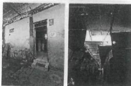
Servicios higiénicos, con columnas; loseta de concreto, con presencia de fallas como desprendimiento de material. Áreas de circulación con techos en deficientes condiciones como calaminas agujereadas., cableado eléctrico expuesto.
