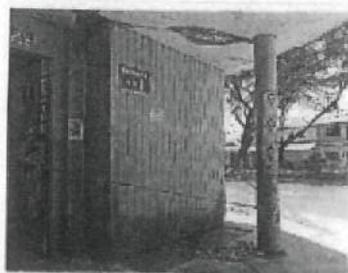
Muro en riesgo de colapso, presentando fallas estructurales como son grietas, fisuras, desprendimiento de material, la cual se encuentra señalizado con cinta amarilla presentando un riesgo para los comerciantes y población.
