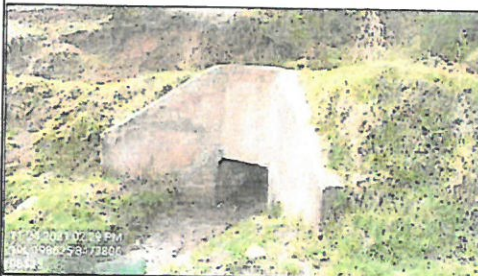
Foto 57: Alcantarilla C°A° Progresiva 53+940
