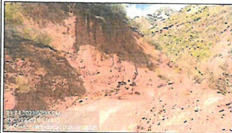
Foto 25: Daño en afirmado y derrumbe Progresiva 55+440
