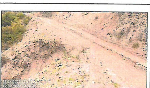
Foto 18: Punto de control - Perdida de plataforma Progresiva 67+500
