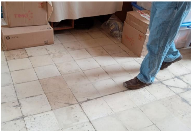
FOTO 11: hundimiento en piso de comunicación.
