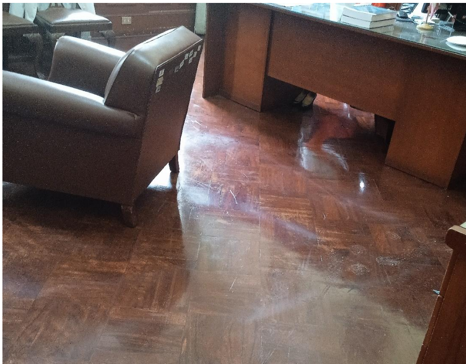
FOTO 18: desnivel del mueble de oficina por hundimiento de piso
