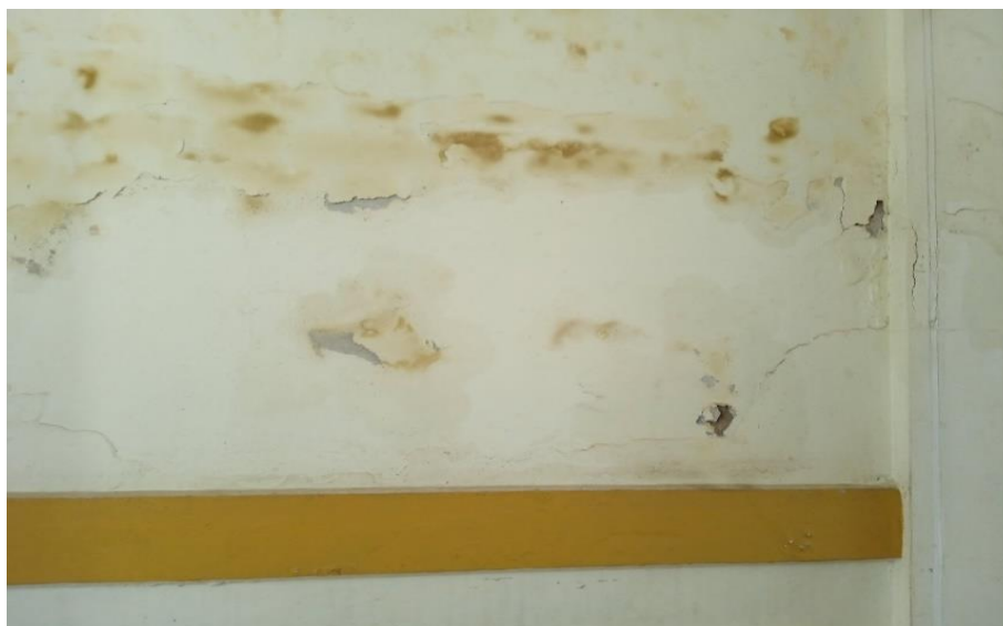
FOTO 01 : presencia de moho y desprendimiento de pintura
