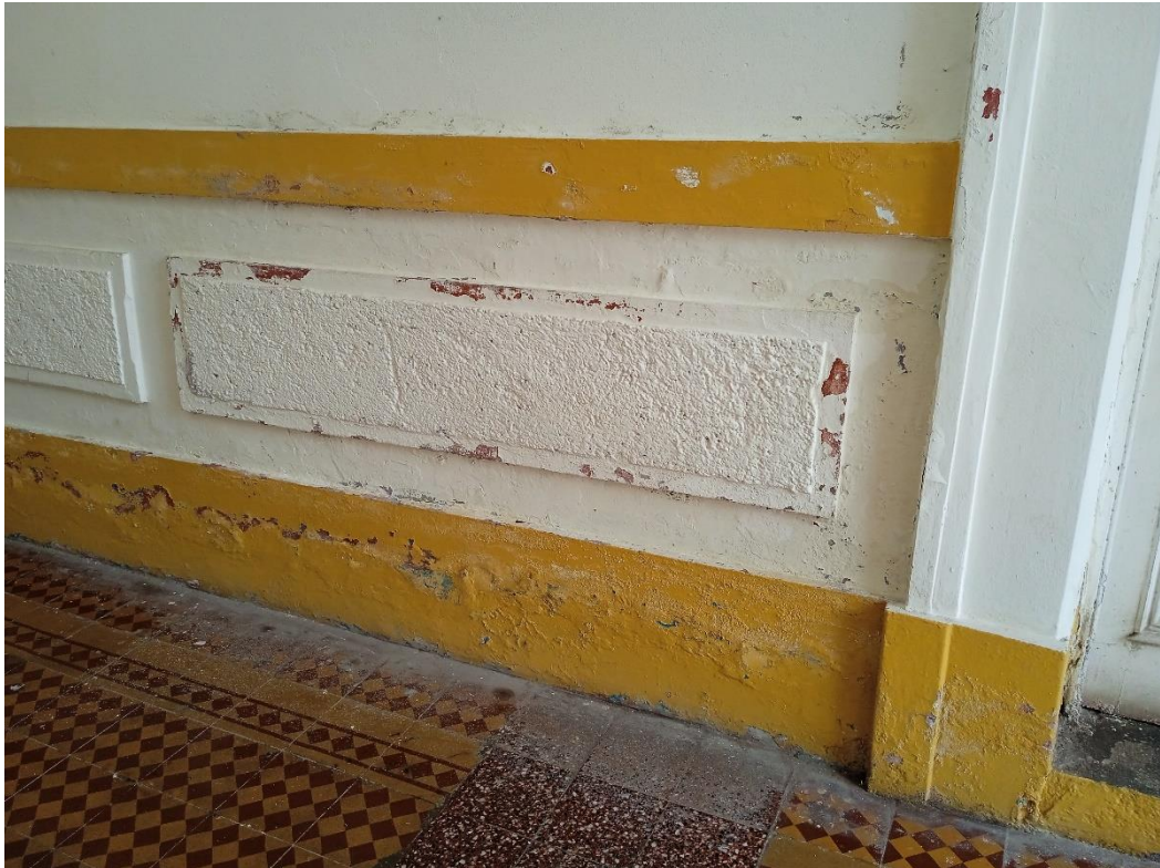
FOTO 03: Desprendimiento de pintura y presencia de humedad
