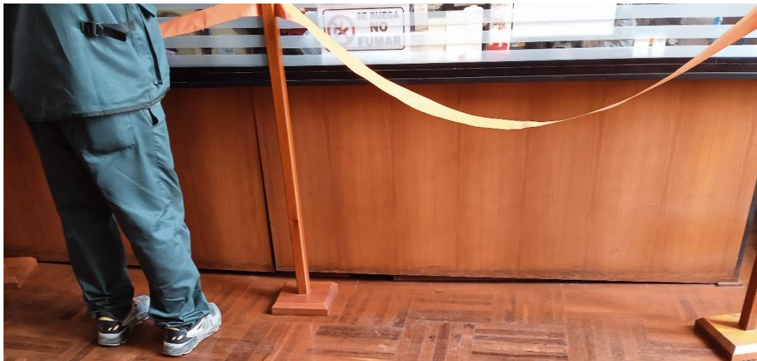
17: desnivel del mueble de oficina por hundimiento de piso
