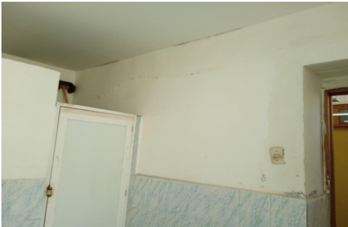
FOTO 08: Presencia manchas de Humedad en muros originales
