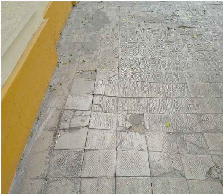
FOTO 20: erosión de superficie de corredor exterior
