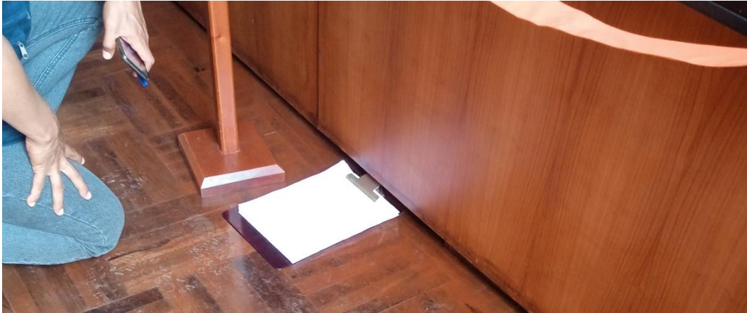
FOTO 16: desnivel del mueble de oficina por hundimiento de piso
