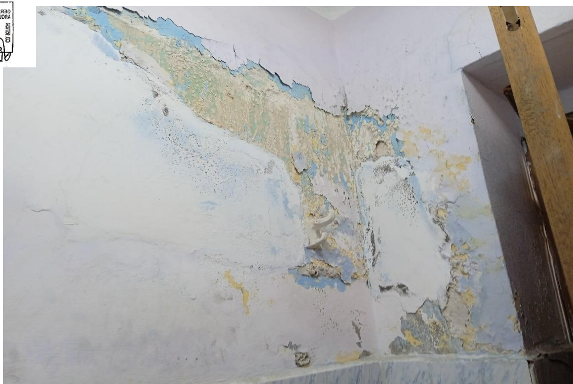
FOTO 09: Erosión de su recubrimiento por humedad en muros.
