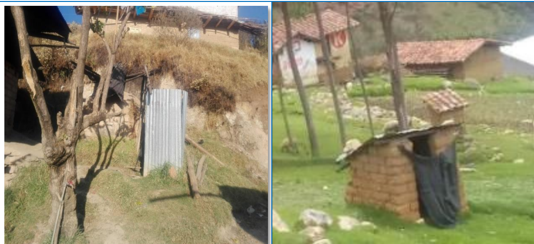
FIG N°37. Letrinas construidas de manera rustica por los pobladores, se encuentran en mal estado, sin ningún tipo de mantenimiento, las letrinas de hoyo seco han sobrepasado su capacidad. Urge su mejoramiento.
