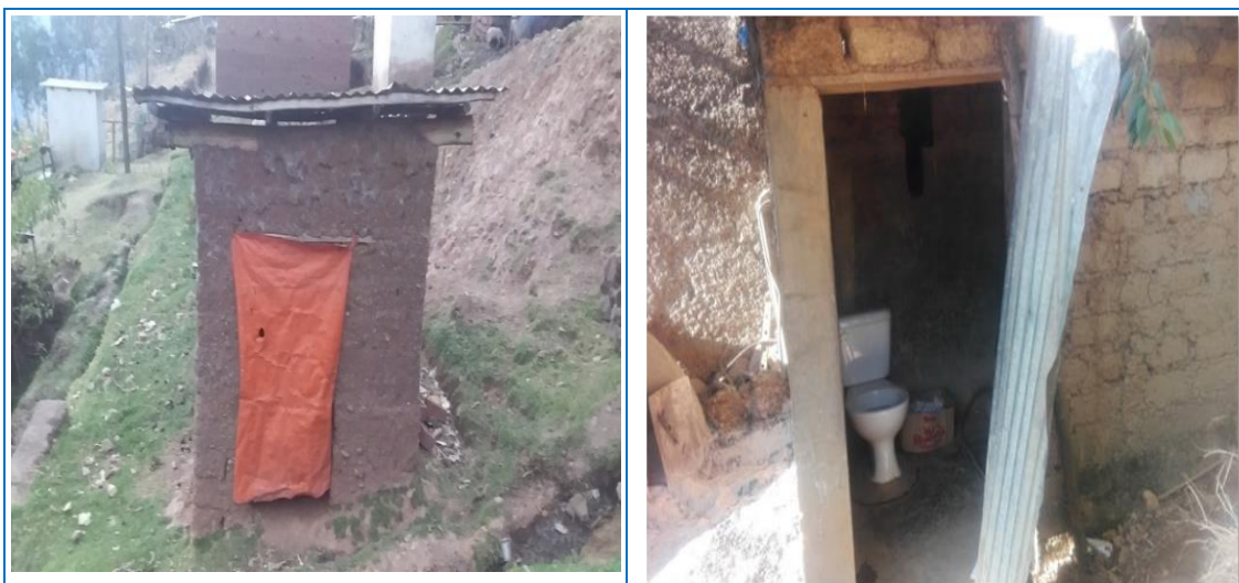
FIG N°33. Letrinas construidas de manera rustica por los pobladores, se encuentran en mal estado, sin ningún tipo de mantenimiento, las letrinas de hoyo seco han sobrepasado su capacidad. Urge su mejoramiento.
