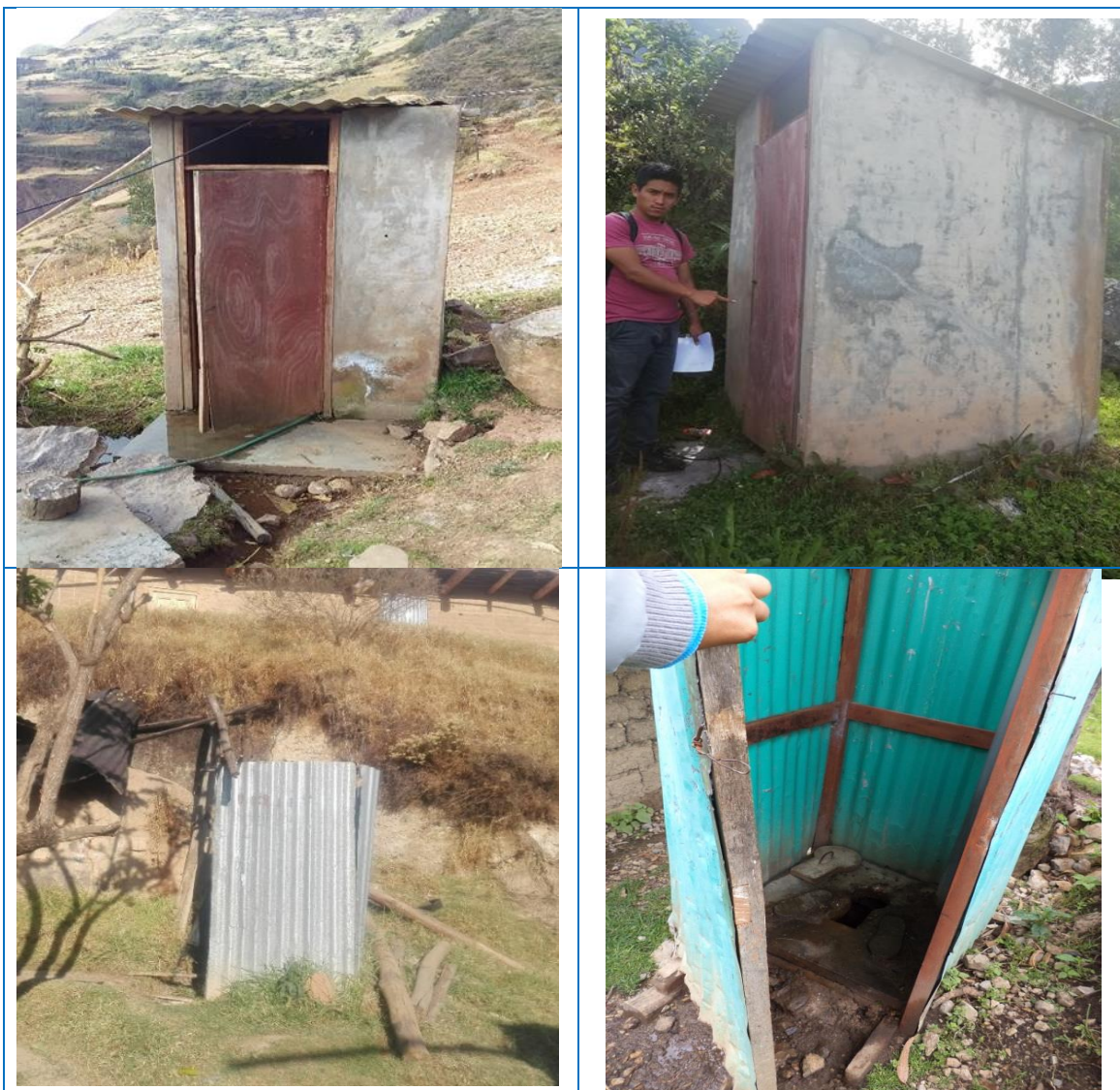
FIG N°34. Letrinas construidas de manera rustica por los pobladores, se encuentran en mal estado.
