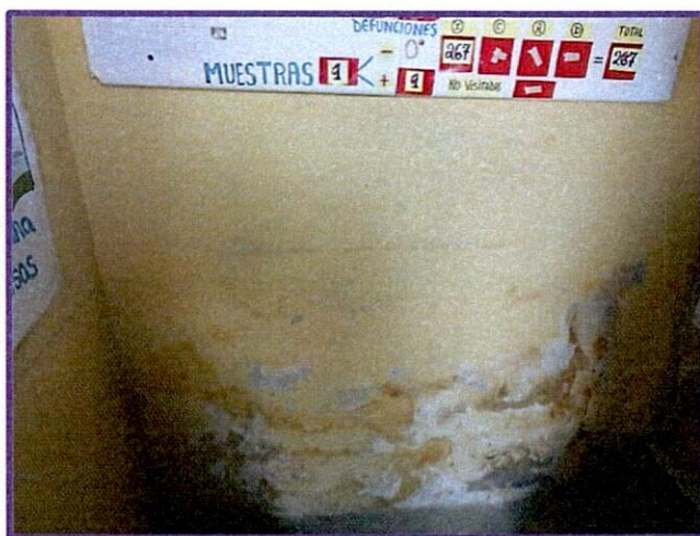
FOTO N° 18: Vista del muro con presencia de salitre en el Puesto de Salud Huanchuy
