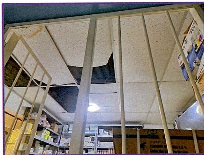
FOTO N° 11: Vista del cielo raso de la farmacia del centro de salud, requiere reposición
