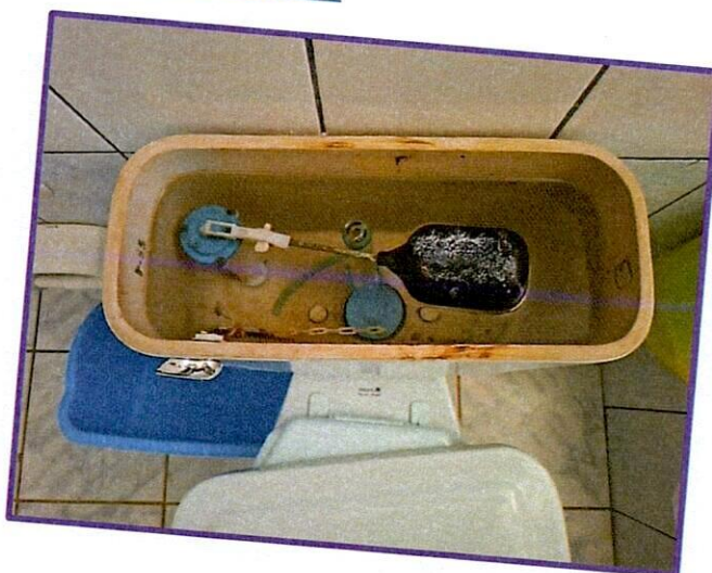
FOTO Nº 13: Vista del estado del tanque bajo del inodoro del Puesto de Salud Chacchán. Requiere renovación.
