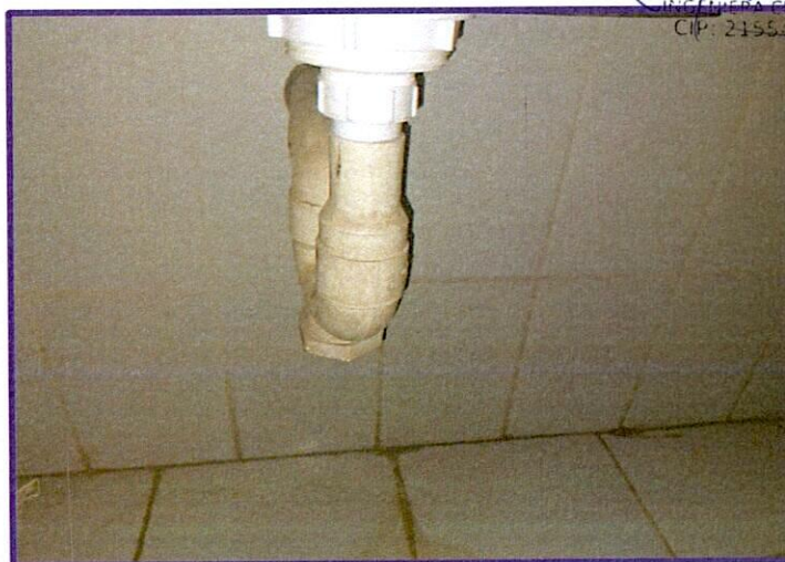
FOTO Nº 03: Vista de la trampa P del lavadero, el cual requiere su reemplazo, por el desgaste inminente
