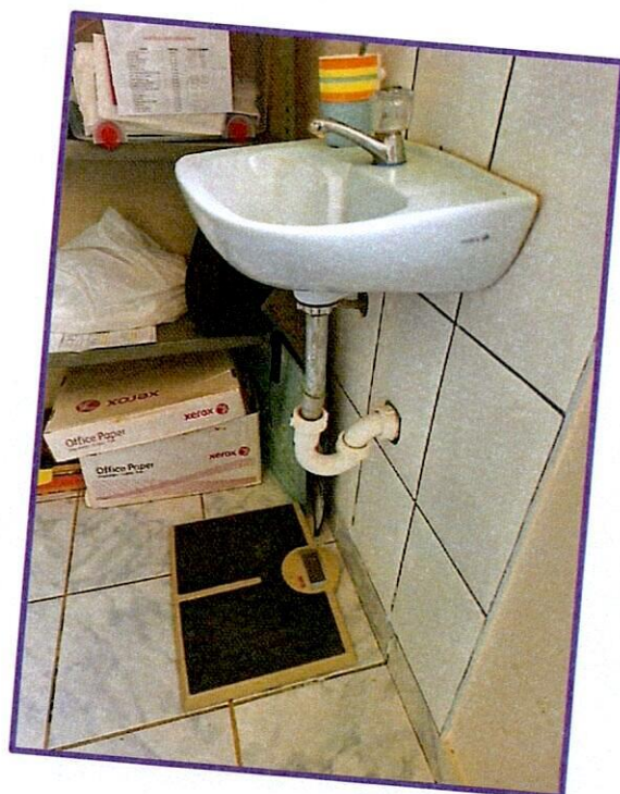
FOTO Nº 14: Vista de la trampa P del lavamanos del Puesto de Salud Chacchán. Requiere renovación
