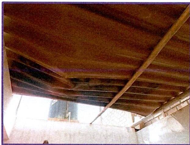
FOTO N° 16: Vista de la cobertura dañada del tanque elevado del Puesto de Salud Huanchuy
