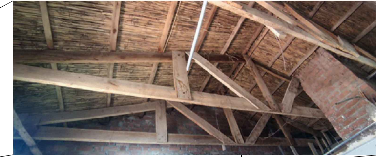
ESTRUCTURA DE TIJERAL DE MADERA EN MAL ESTADO
