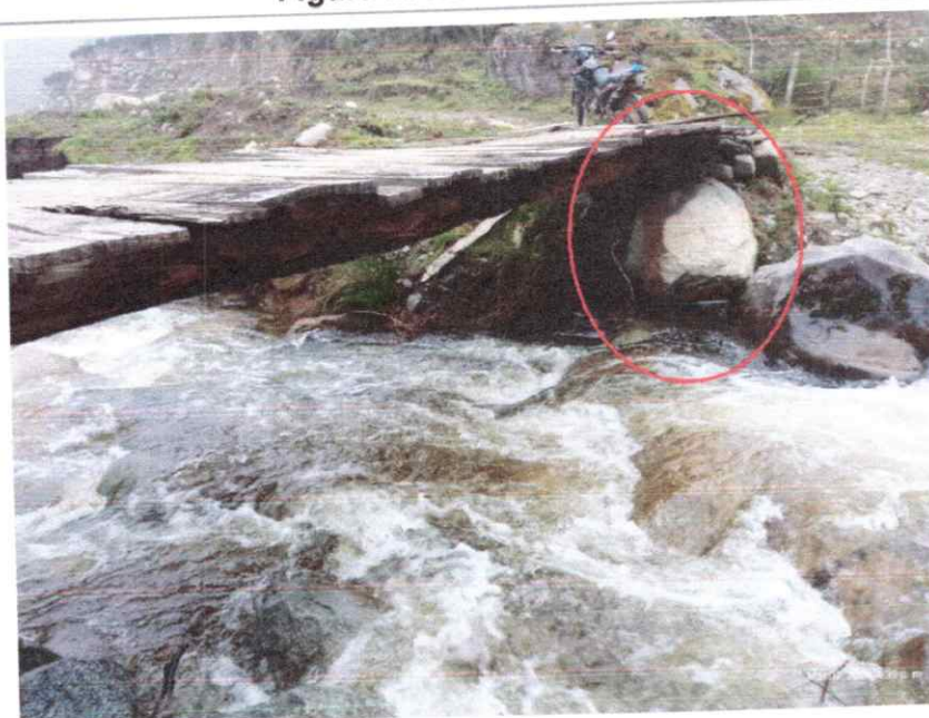
Figura 6: Estribo derecho PUENTE BLANCO
