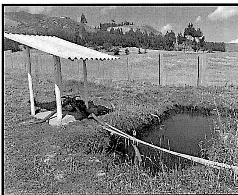
Foto 02: Bombeo de agua hacia la cisterna existente.
