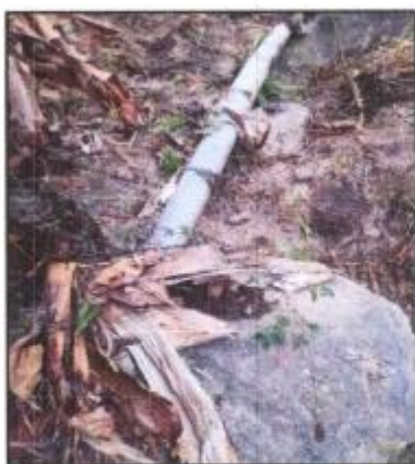
Fotografía N°16: Tubería dañada toma-03 Fuente: Elaboración Propia
