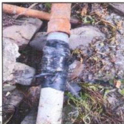
Fotografía N°41: Tubería dañada toma-01 Fuente: Elaboración Propia
