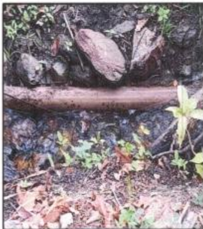
Fotografía N°82: Tubería aducción expuesta toma 01 Fuente: Elaboración Propia
