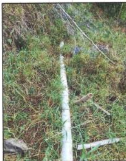
Fotografía N°46: Tubería dañada toma-02 Fuente: Elaboración Propia
