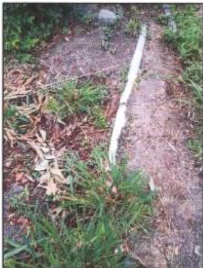
Fotografía N°39: Tubería dañada toma-03 Fuente: Elaboración Propia
