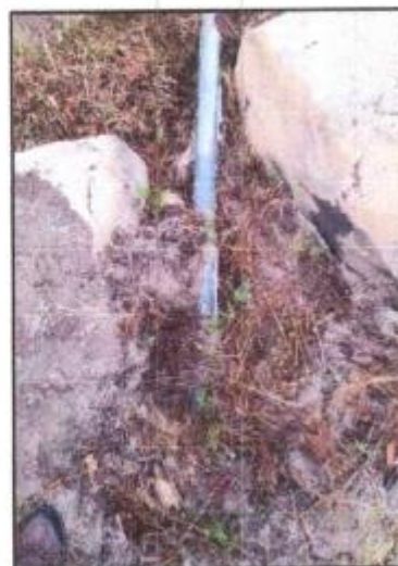
Fotografía N°30: Tubería dañada toma-04 Fuente: Elaboración Propia
