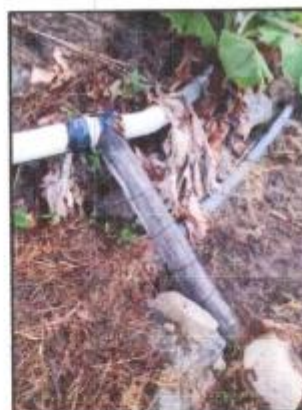
Fotografía N°15: Tubería dañada toma-02 Fuente: Elaboración Propia
