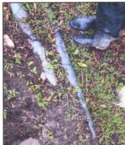
Fotografía N°19: Tubería dañada toma-02 Fuente: Elaboración Propia
