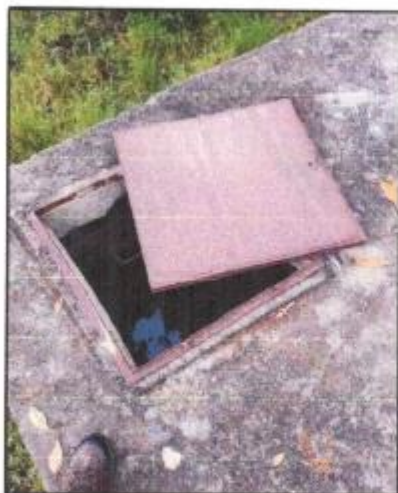
Fotografía N°80: Tapa de ingreso deteriorado Fuente: Elaboración Propia
