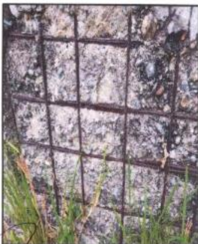
Fotografía N°78: Reservorio apoyado, evidencia acero Fuente: Elaboración Propia
