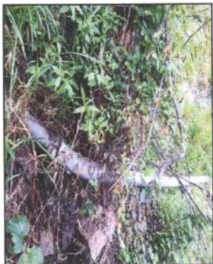
Fotografía N°33: Tubería dañada toma-03 Fuente: Elaboración Propia
