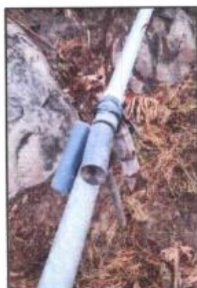
Fotografía N°14: Tubería dañada toma-01 Fuente: Elaboración Propia
