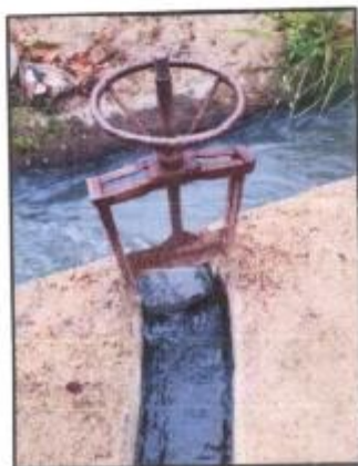
Fotografía N°06: Compuerta canal de higuerones Fuente: Elaboración Propia
