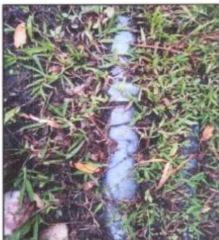
Fotografía N°20: Tubería dañada toma-03 Fuente: Elaboración Propia
