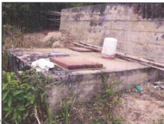
Fotografía N°76: Caja de control de salida Fuente: Elaboración Propia
