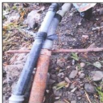
Fotografía N°42: Tubería dañada toma-02 Fuente: Elaboración Propia
