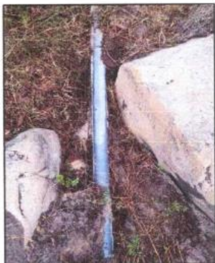
Fotografía N°28: Tubería dañada toma-03 Fuente: Elaboración Propia
