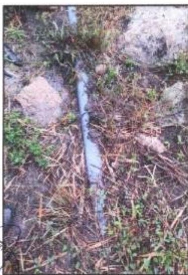
Fotografía N°22: Tubería dañada toma-01 Fuente: Elaboración Propia
