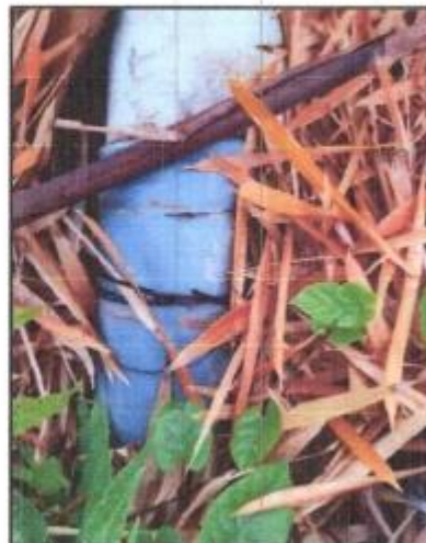
Fotografía N°40: Tubería dañada toma-04 Fuente: Elaboración Propia
