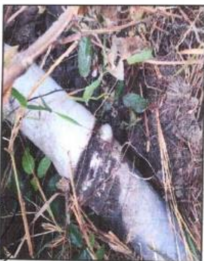
Fotografía N°31: Tubería dañada toma-01 Fuente: Elaboración Propia
