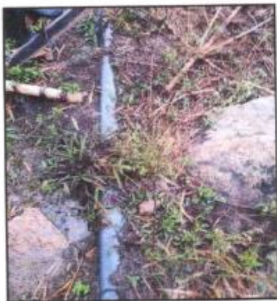
Fotografía N°24: Tubería dañada toma-03 Fuente: Elaboración Propia
