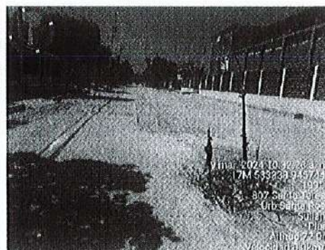
CALLE SANTA TERESA, AL FONDO TV. SAN HILARION CALLE SANTA TERESA CON CANAL COLA DEL ALACRAN EN AMBAS TOMAS OBSERVAR EL MUY MAL ESTADO DEL PAVIMENTO SEMIFLEXIBLE.
