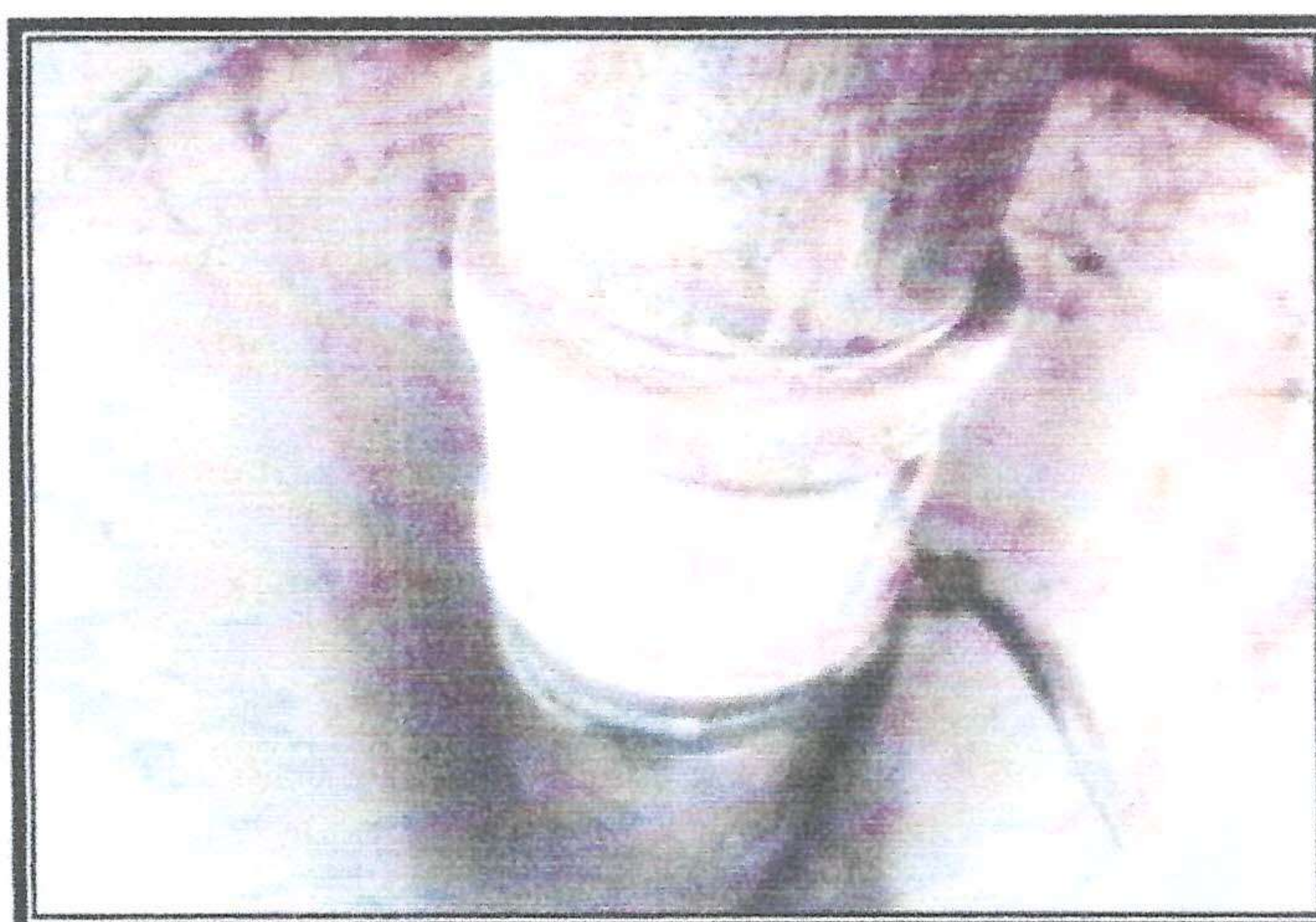
Imagen N°13: tubería de fierro galvanizado de 2"
