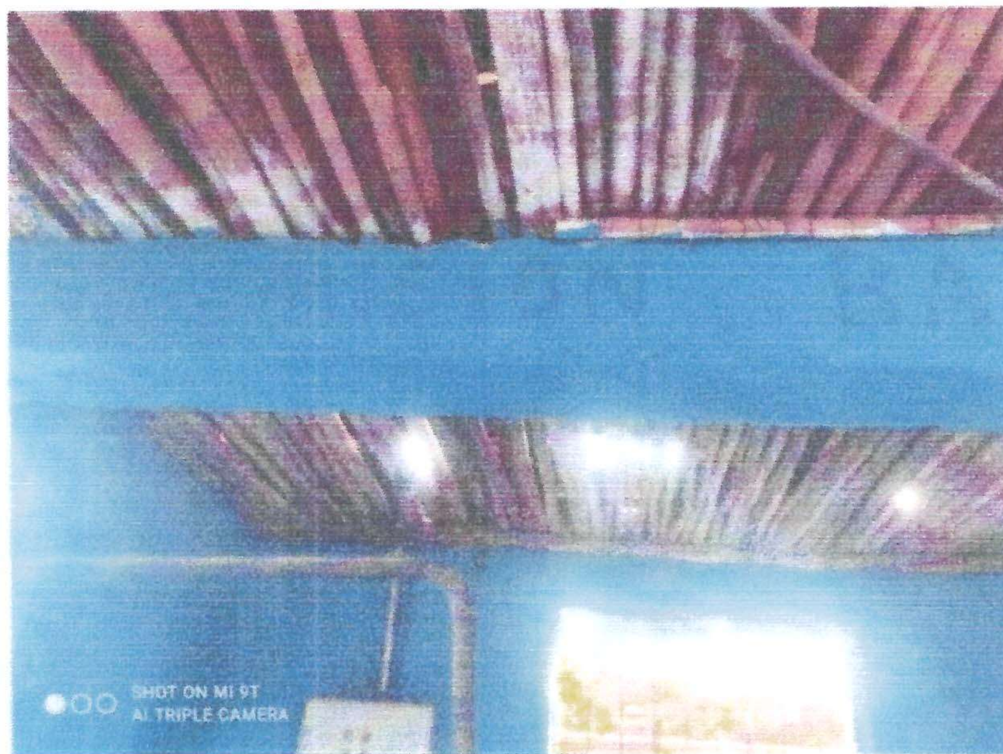
Imagen N°07: techo de carrizo Caseta de Pozo tubular “El motor”
