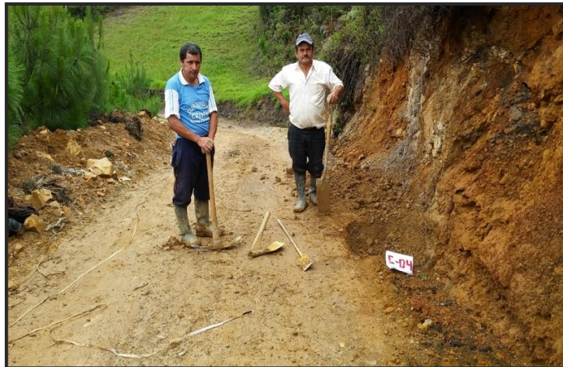
Fotografía 2. Estado actual de la carretera a media ladera, por tanto, aumentar el ancho de calzada implica trabajos de corte excesivos.
