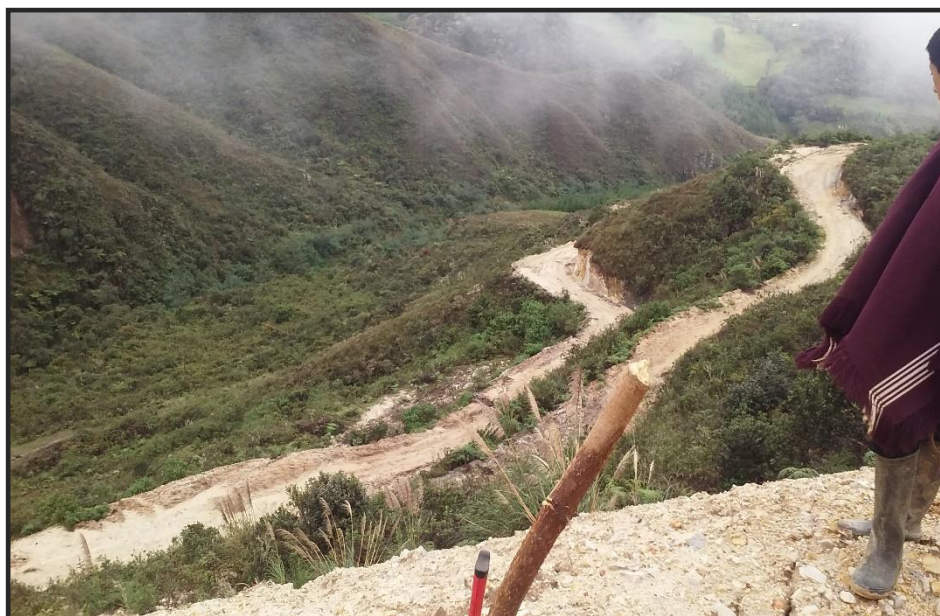
Fotografía 3. Estado actual de la carretera a media ladera, por tanto, aumentar el ancho de calzada implica trabajos de corte excesivos.
