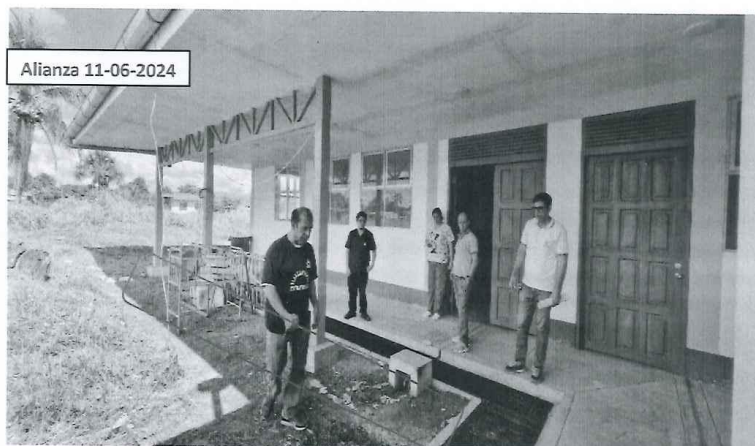
FOTO 24.- AMPLIACIÓN DE VEREDA CON FALSO PISO DE CONCRETO A NIVEL DE CUNETA, ADEMÁS DE LA NIVELACIÓN DE UNA CAJA DE REGISTRO
