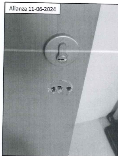
FOTO 15.- CERRADURAS EN MAL ESTADO
