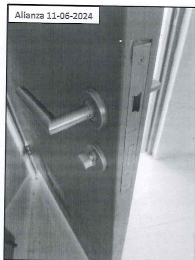
FOTO 16.- CERRADURA CON EL PIN MALGRADO.
