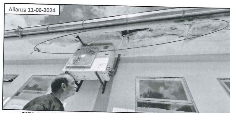
FOTO 6.- CIELO RASO PRESENTA DETERIORO EN VOLADO EXTERIOR IZQUIERDO
