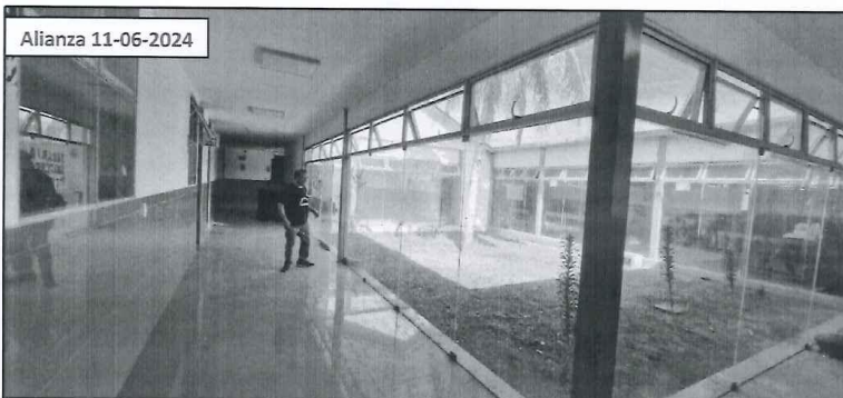
FOTO 9.- MUROS CORTINA A MODIFICAR CON TUBOS METALICOS PARA MEJORAR ESTABILIDAD Y ABRIENDO MAMPARAS EN LOS CUATRO LADOS DEL JARDIN CENTRAL PARA MEJORAR LA VENTILACIÓN EN LOS AMBIENTES INTERIORES.
