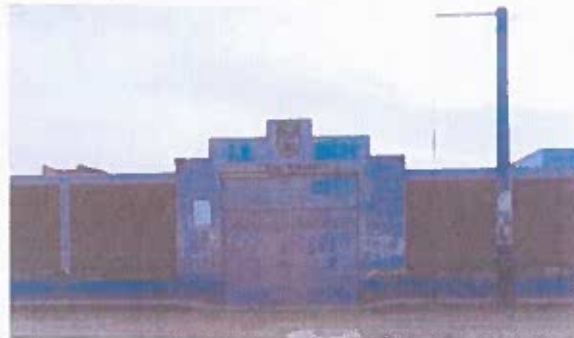
FOTO N°01 - I.E. N° 10824 DE LA LOCALIDAD SAN NICOLAS Paredes agrietadas y con revestimiento desprendido
