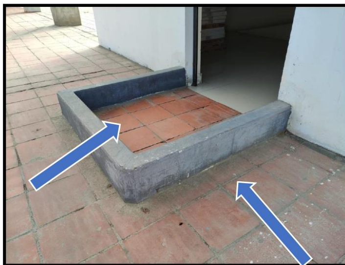
Zócalos a revestir por donde se ubica la salida de la escalera en toda la longitud de h=20\text{ cm}
