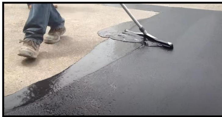
Imagen Referencial de la imprimación con imprimante asfáltico a base de agua de aplicación en frío.
