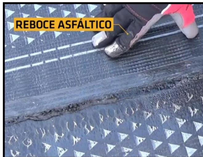
Imagen donde se muestra los traslapes longitudinales entre Mantos Asfálticos
