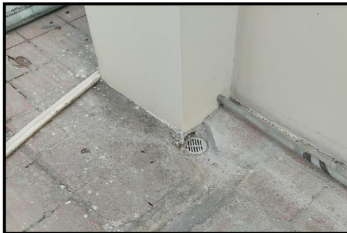
Sumideros existentes a recubrir. Esta partida comprende la rejilla metálica tipo corona
