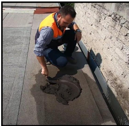
Imagen referencial de la aplicación del mortero asfáltico en el área a intervenir.
