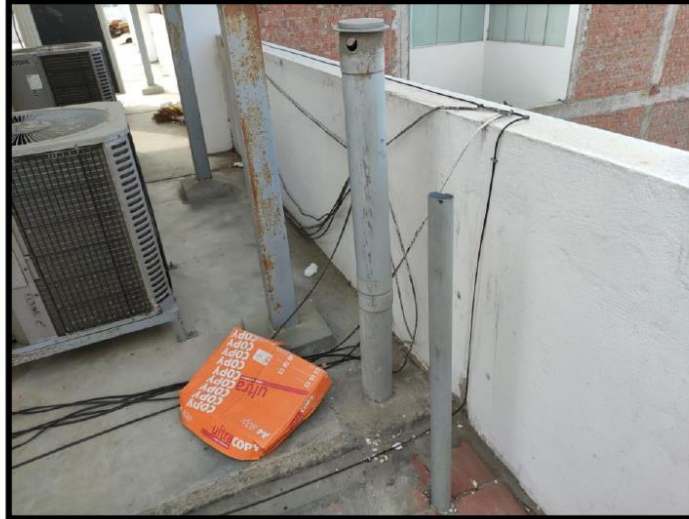
Tuberías a recubrir, son tuberías de PVC que funcionan como ductos de ventilación de los pisos inferiores.
