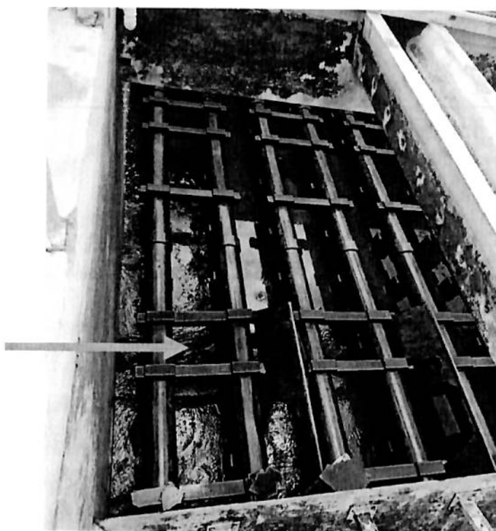
FIG. N° 02 – C: Soporte móviles de concreto, soporte de Planchas Tranquilizadora.
