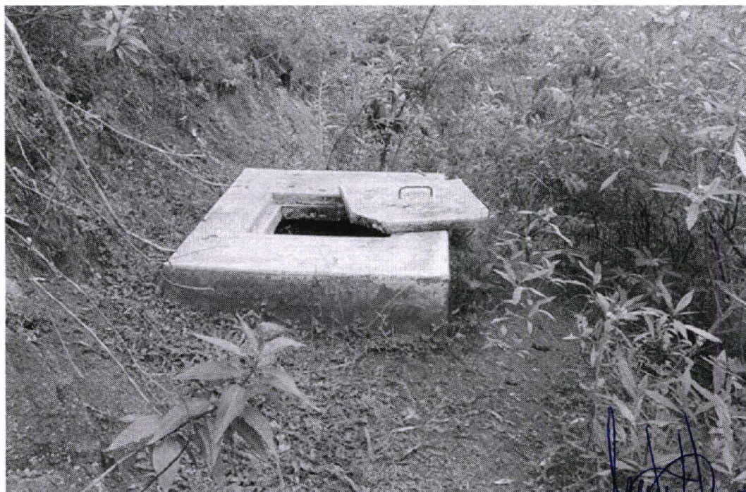
Figura 07: Caja de inspección deteriorada
