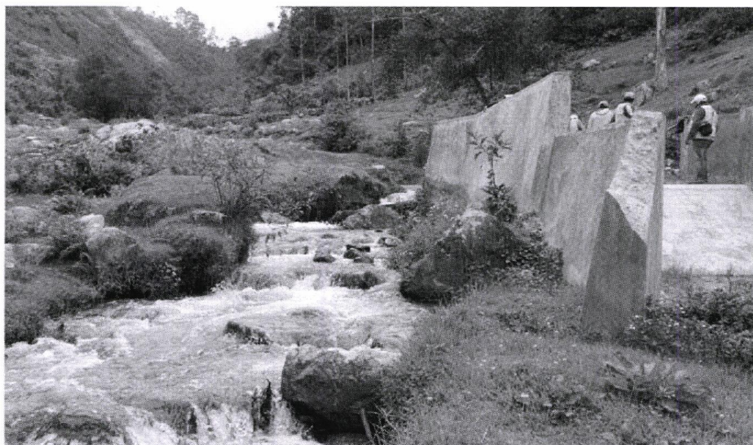
Figura 01: Bocatoma deteriorada en sus extremos y derivación del caudal.
