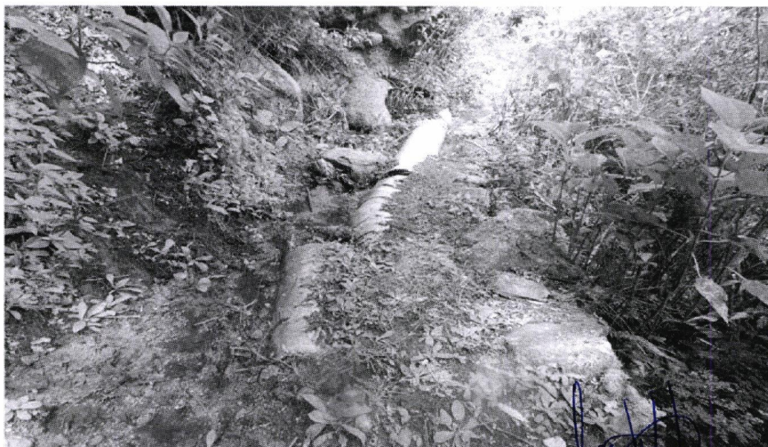
Figura 04: Tubería deterioradas
