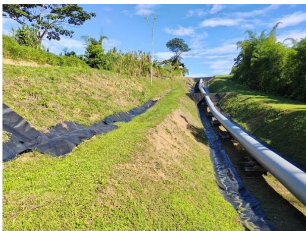
Gráfico N° 10.- Instalación de Geomembrana sobre cunetas
