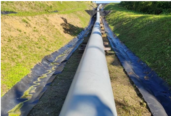
Gráfico N° 10.- Instalación de Geomembrana sobre cunetas
