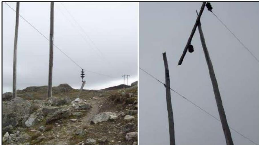
Fig. N° 04: Postes de madera de media tensión deteriorados
