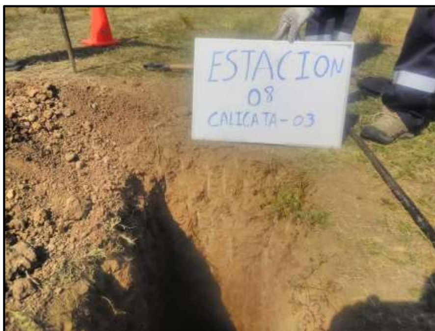
Fotografía N° 2: Excavación Manual de Calicatas
