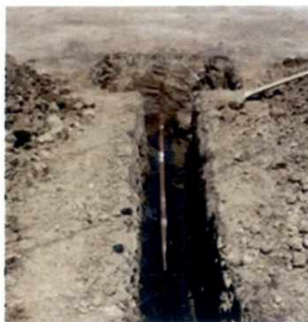
Vistas 2 del proceso de instalación de poza atierra horizontal (Imagen referencial)
