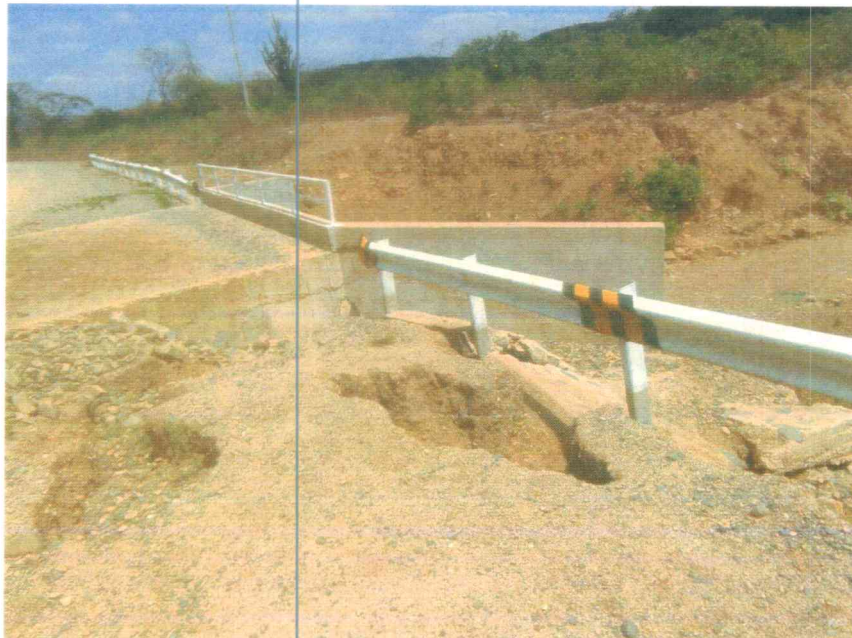
EROSION LATERAL POR FALTA DE CUNETA COLAPSO DE PARTE DE LA BASE
