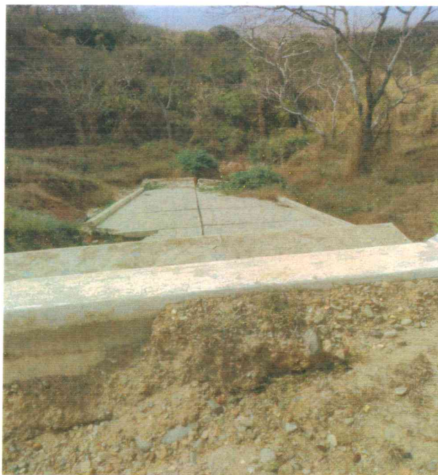
COLAPSO DE SALIDA DE ENROCADO DE ALCANTARILLA POR LA FALTA DE CUNETAS
