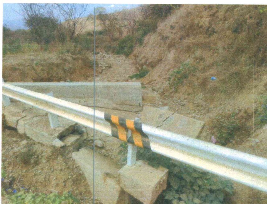
EXPOSICION DE DADOS DE GUARDAVIAS POR FALTA DE CUNETAS
