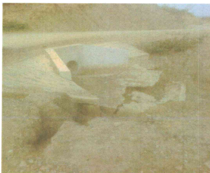
DESPLOME DEL ENROCADO DE SALIDA DE ALCANTARILLA POR FALTA DE CUNETETA EL AGUA INGRESO LATERALMENTE
