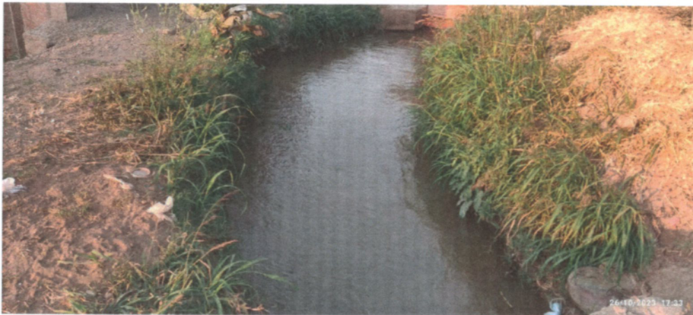
FOTOGRAFÍA 10: La imagen muestra el estado actual del tramo de canal en terreno natural y la presencia de agua lo cual muestra que el canal en la actualidad se viene utilizando por los agricultores para regadío de sus cultivos, así mismo se muestra la existencia de vegetación minúscula en los bordos.
