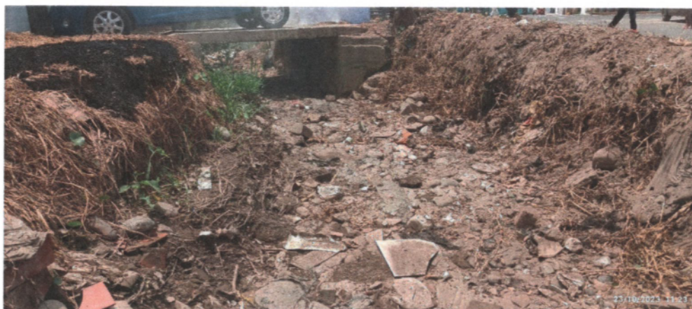
FOTOGRAFÍA 06: La imagen muestra la estructura existente de alcantarilla artesanal la cual debe ser demolida por el contratista para ser instalado las estructuras según los planos y la progresiva correspondiente.
