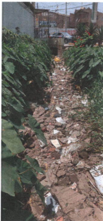
FOTOGRAFÍA 01: La imagen muestra la alcantarilla existente en el cruce del Pasaje San Francisco en la cual se debe empalmar la construcción de la etapa II del proyecto, la llegada debe formar una junta.
