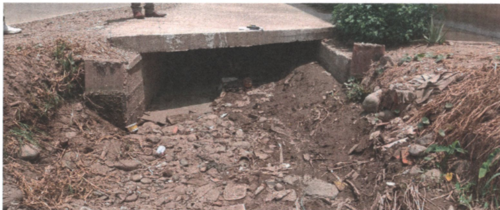
FOTOGRAFÍA 07: La imagen muestra la estructura existente de alcantarilla artesanal la cual debe ser demolida por el contratista para ser instalado las estructuras según los planos y la progresiva correspondiente.
