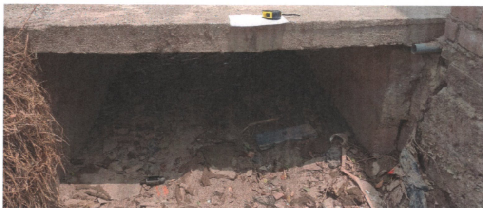
FOTOGRAFÍA 04: La imagen muestra la estructura existente de alcantarilla artesanal la cual debe ser demolida por el contratista para ser instalado las estructuras según los planos y la progresiva correspondiente.
