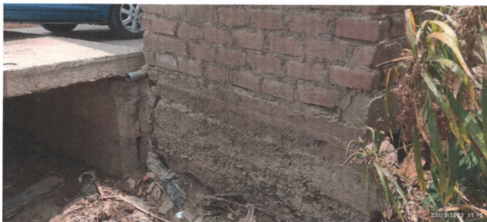
FOTOGRAFÍA 05: La imagen muestra la estructura existente de alcantarilla artesanal la cual debe ser demolida por el contratista para ser instalado las estructuras según los planos y la progresiva correspondiente.
