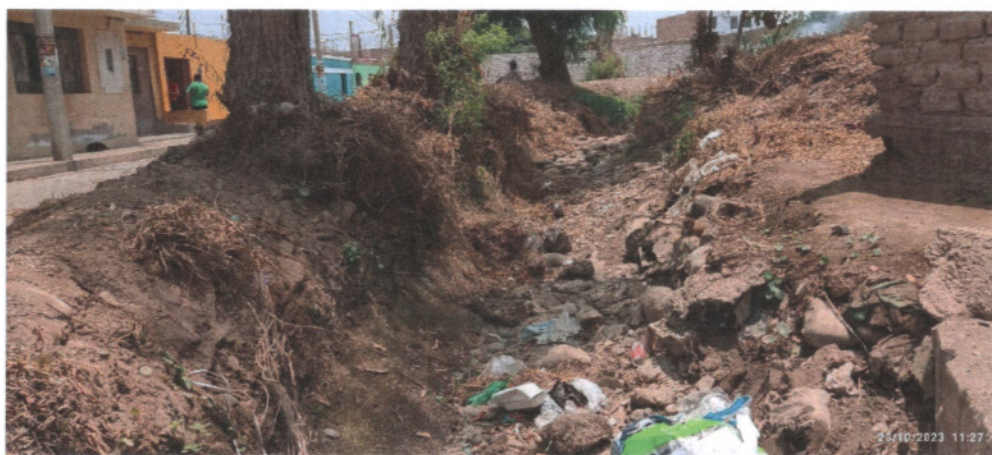
FOTOGRAFÍA 08: La imagen muestra el estado actual del tramo de canal en terreno natural y la presencia de árboles que el contratista no deberá talar los cuales existen en los bordos y así como la existencia de residuos sólidos arrojados por los vecinos cercanos.
