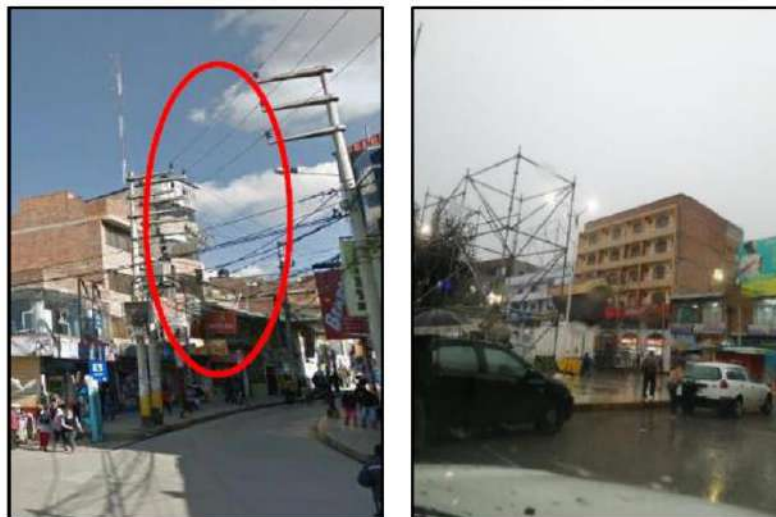
Fig. N° 06: Incumplimiento de las distancias mínimas de seguridad
