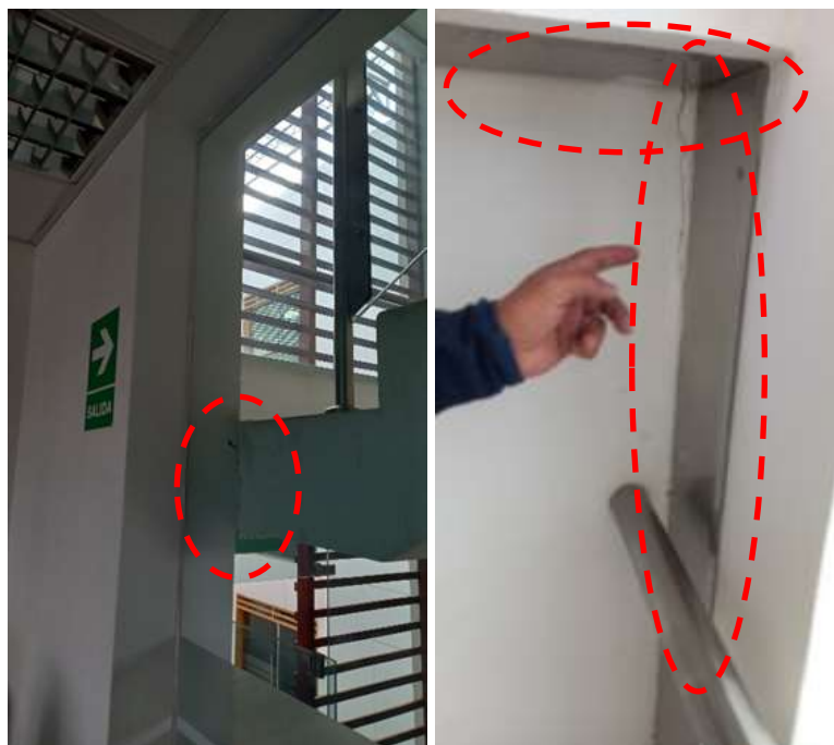
Imágenes N° 11 y 12: Algunas rajaduras en la superficie interior del muro de la escalera.
