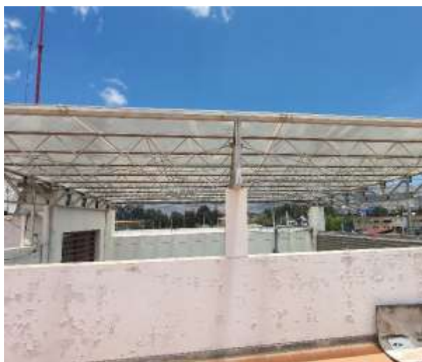
Imágenes N° 15 y 16: Parte de la cobertura de policarbonato, en la Azotea.
