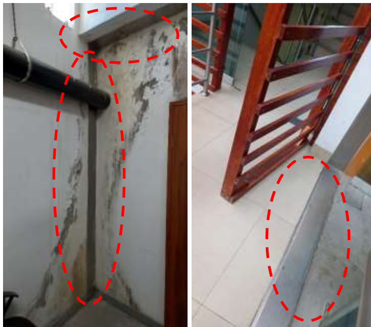
Imágenes N° 07 y N° 08: Algunas tapajuntas metálicas vertical y horizontal.
