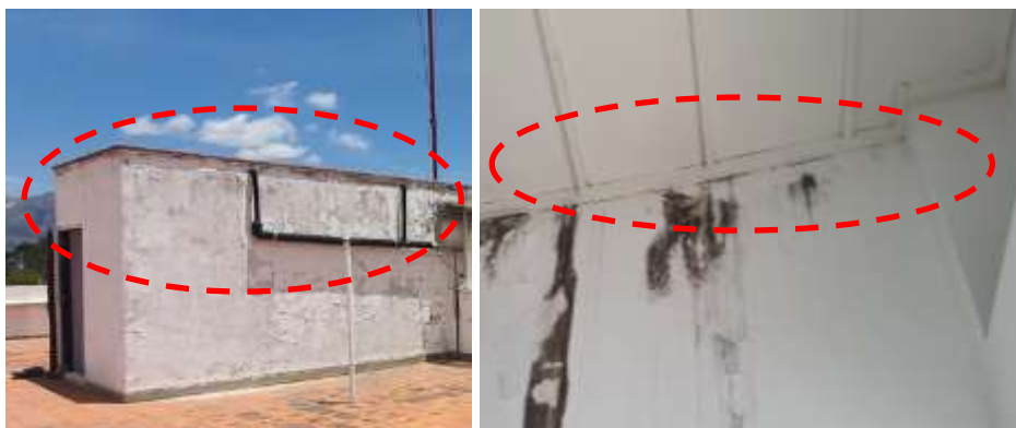
Imágenes N° 26 y 27: Encuentros entre muro y el techo de la escalera exterior – interior.
