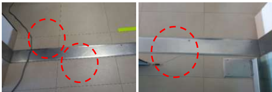
Imágenes N° 13 y 14: Algunas piezas de porcelanato rajadas, en Tramite Documentario y SINAD, en el primer piso.
