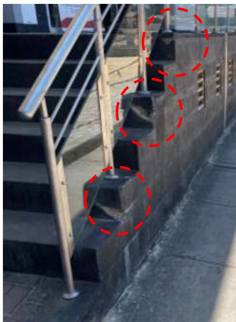
Imagen N° 40: Gradas a reparar en el ingreso del primer piso.
