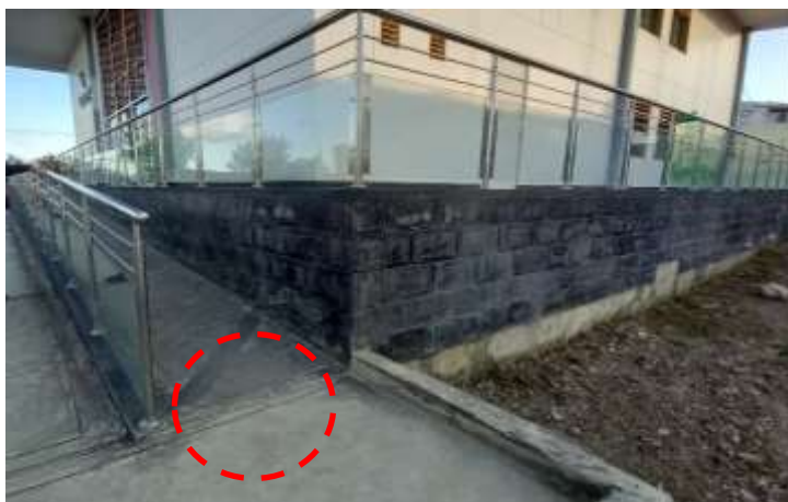
Imagen N° 06: Parte de la junta de construcción en el primer piso (piso de adoquines) encuentro con la vereda pública).
