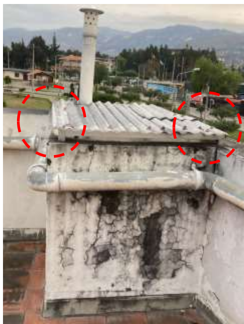
Imagen N° 22: El cambio de la cobertura de policarbonato, cubrirá 10cm. hacia los laterales.
