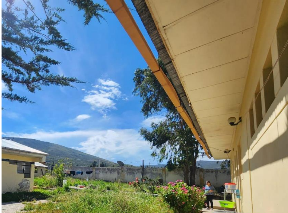
F6: Retiro y reposición de canaleta pluvial
