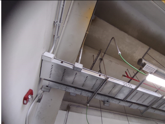
Bandejas metálicas para cableado
