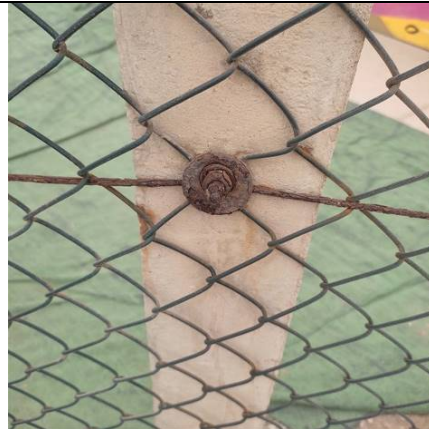
Deterioro de los sujetadores
