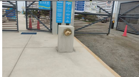
Conexión de doble toma
