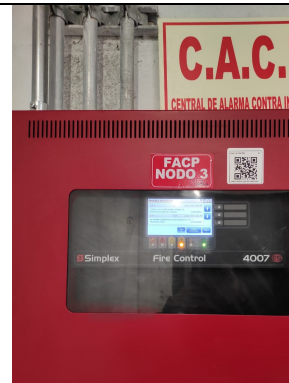
Panel centralizado de detección y alarma contra incendio con señal de alerta activada
