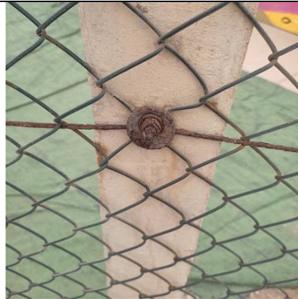
Deterioro de los sujetadores
