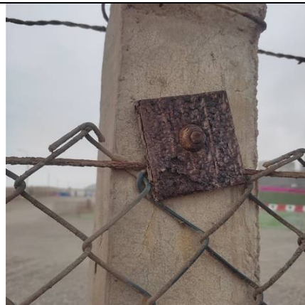
Deterioro de los sujetadores de la malla metálicas
