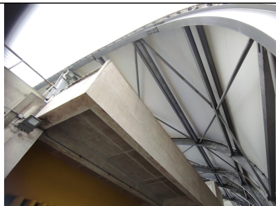
Techo parcial de estructuras metálicas con lona tipo toldo
