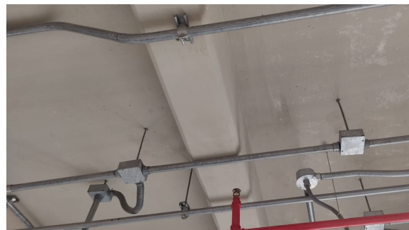
Cableado eléctrico y aspersor
