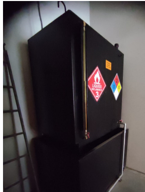
Tanque de combustible de grupo electrógeno
