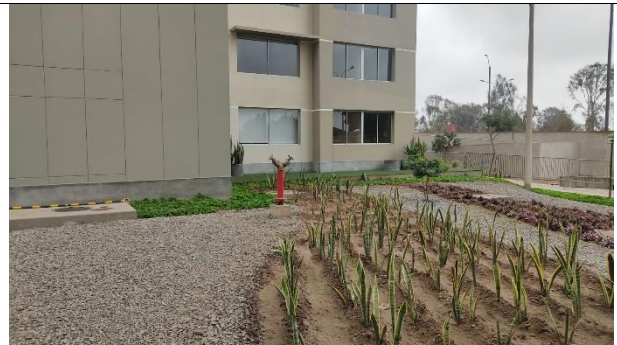
Conexión doble de manguera
