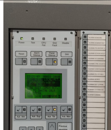
Panel central del sistema de detección con fallas y silenciado
