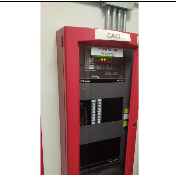
Panel central del sistema de detección
