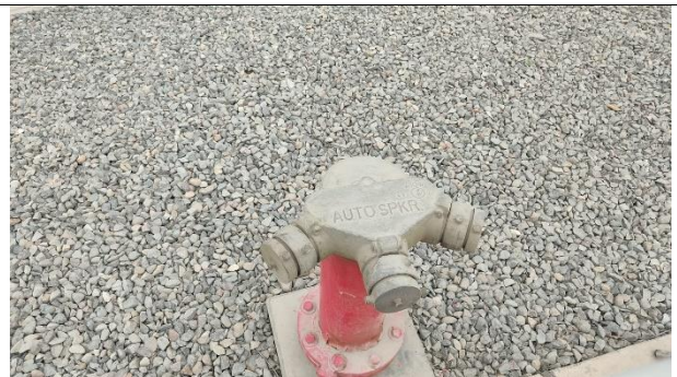
Conexión triple de manguera
