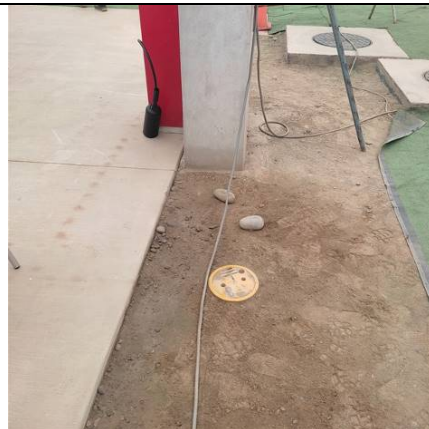
Vista de un pozo a tierra, cercano a los tableros eléctricos del espacio deportivo
